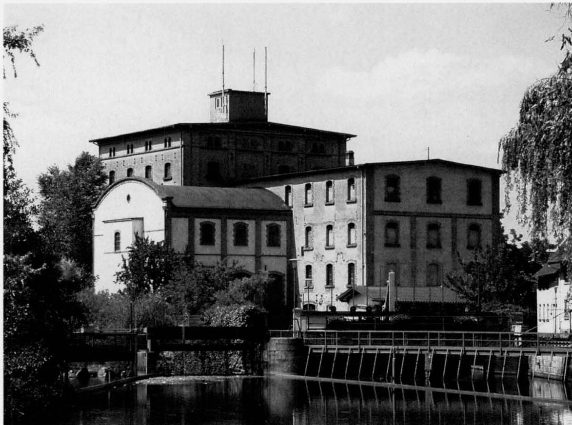
Anbau des Elektrizitätswerkes anno 1910
