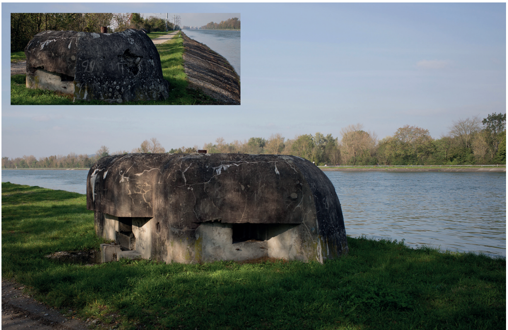
Fig. 9: Blockhaus de berge de type Garchery (secteur de Village-Neuf). Abb. 9: Uferbunker vom Typ Garchery (Sektor von Village-Neuf).
