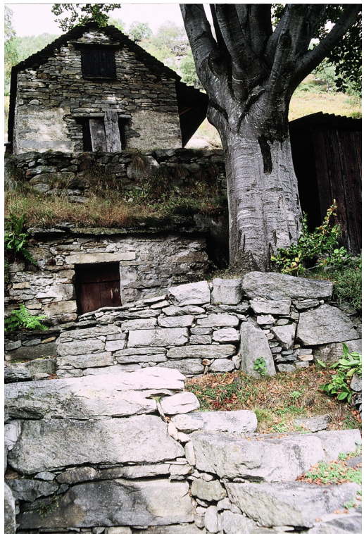
Abb. 9: Wohnhaus, Kaltkeller und Terrassierung in Bruchsteinmauerwerk. Nutzung des steilen Terrains unter Verwendung lokaler Baumaterialien mit beispielhafter handwerklicher Umsetzung der Bauaufgabe. Mergoscia, Bresciadiga. Foto: Benno Furrer, 2003.
