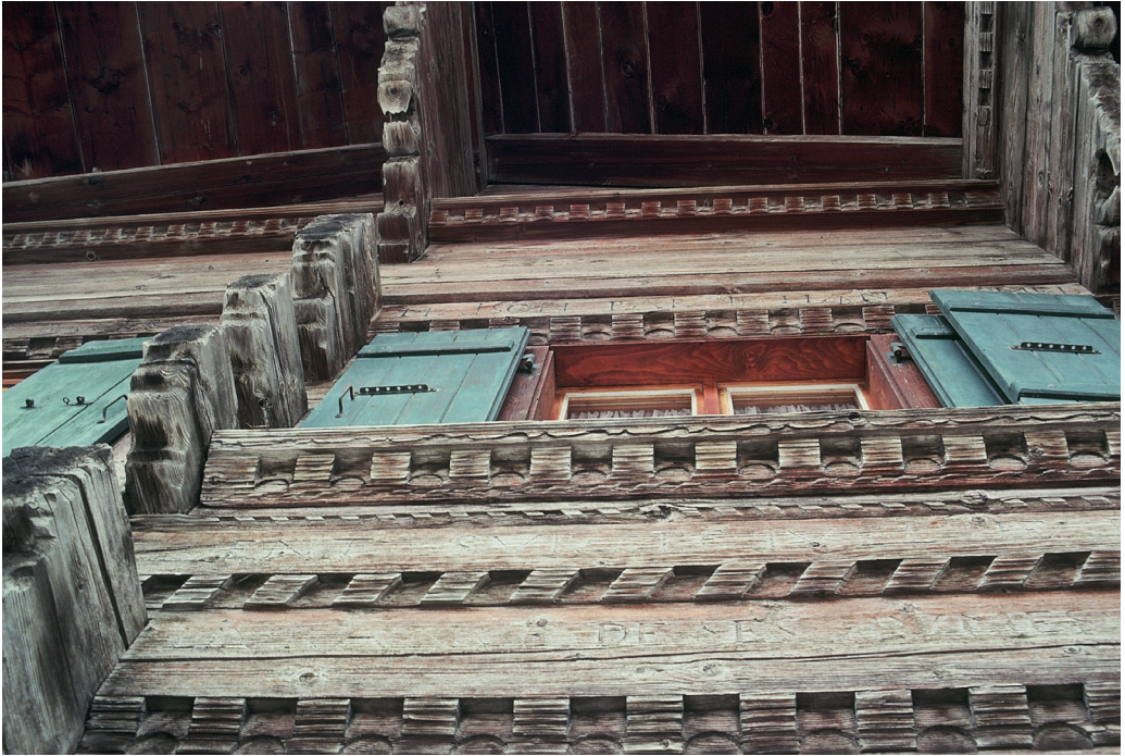
Abb. 5: Fassade mit diversen Friesen und geschnitzten Holzornamenten. Les Moulins (VD), 1659. Foto: Benno Furrer, 1991.
