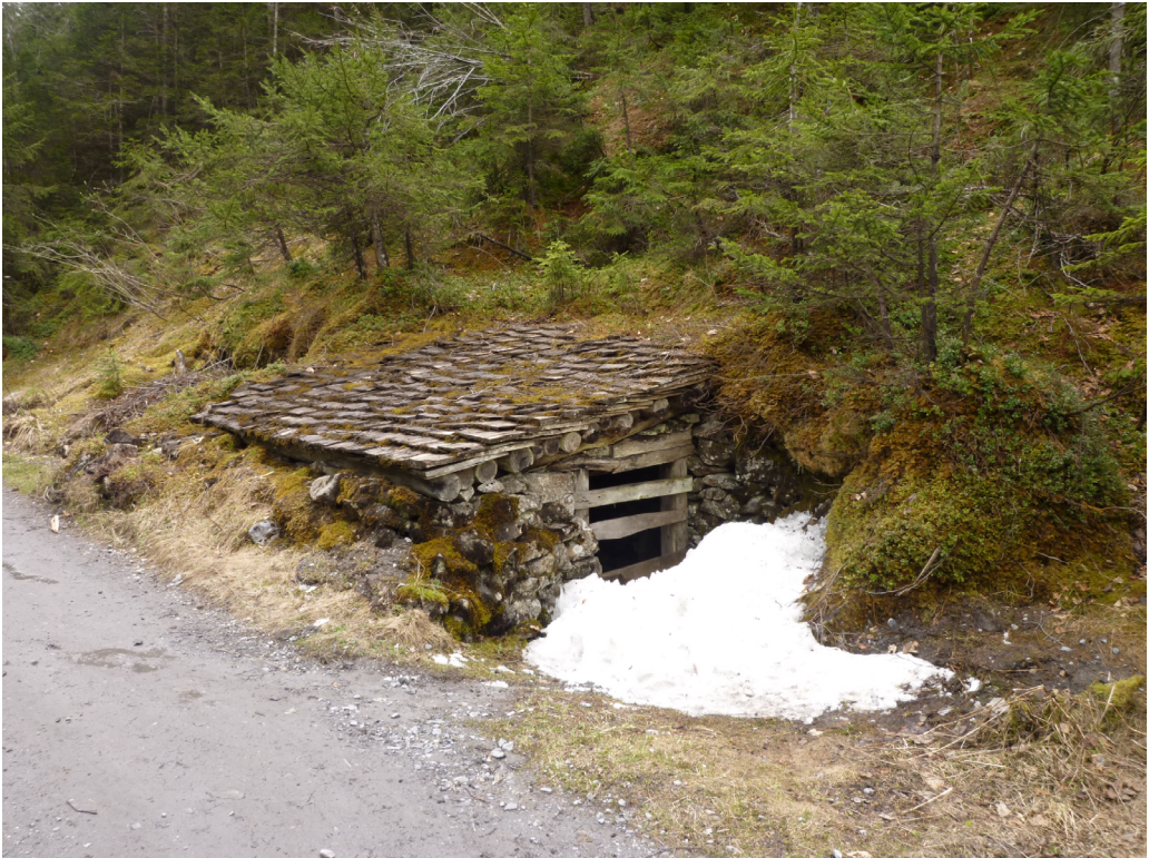
Abb. 2: Kaltkeller am Fusse einer Geröllhalde. Hier werden kühlende Luftströmungen genutzt, um Milch und Fleisch frisch zu halten. Unterschächen, Nitleren, 995 m ü. M. Foto: Benno Furrer, 2010.
