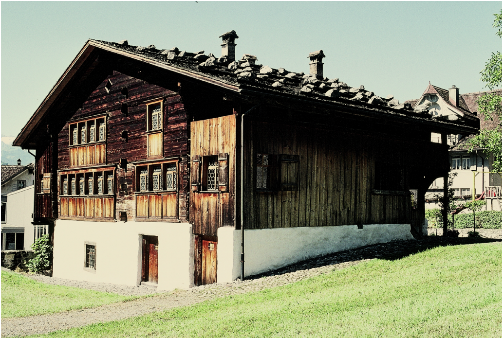
Abb. 3: Wohnhaus mit fassadensichtigen Boden-/Deckenbohlen, erbaut 1287. Blockbau mit Schindeldach. Umbau Kellergeschoss 1544, Anbau seitliche Kammern 18. Jahrhundert. Foto: Benno Furrer, 2001.
