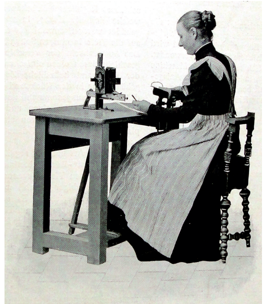
Abb. 12: Klassischer Arbeitsplatz einer Heimarbeiterin: Büschelmaschine „Ideal“ mit Fußantrieb und Bankschere (rechts außen) zum Begradigen der Haare/Borsten. Zahoransky lieferte diese „Bündelabteil (Einzieh-) Maschine“ bereits kurz nach Firmengründung 1902. Ausschnitt aus einem Firmenprospekt. Archiv Benno Dörflinger, Todtnau.
