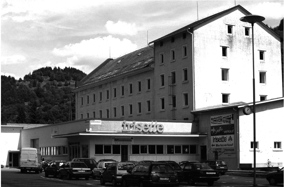
Abb. 12: Ehemaliges Werkgebäude der Zell-Schönau AG in Schönau, teilweise durch Einzelhandel umgenutzt. Foto: Cornelia Korff, 1998
