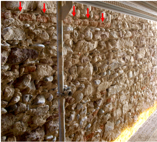
Abb. 6: Hochmittelalterliches Mauerwerk im Westgiebel von Haus A, Backsteinbank einer Maueröffnung in der Giebelmitte. Foto und Pfeile: Frank Löbbbecke, 2010.
