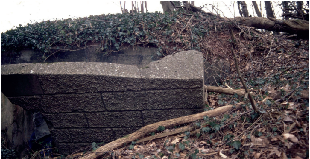
Abb. 2: Bei den Bauwerken wurde Wert auf eine ausreichende Tarnung gelegt. Dieser MG-Schartenstand einer Sperrstelle im Schwarzwald wurde im Bereich der Schartenplatte mit einer Vorsatzschale ausgestattet, die wie eine Stützmauer aussah. Foto: Friedrich Wein.
