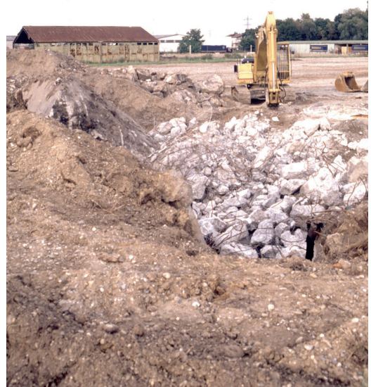
Abb. 20: Trotz seines Nutzens für den Naturschutz ging der Substanzverlust weiter, insbesondere als nach dem Ende des „Kalten Krieges“ zahlreiche Kasernen aufgelassen wurden, in denen sich wie hier Bunker des Westwalls befanden. Foto: Friedrich Wein.
