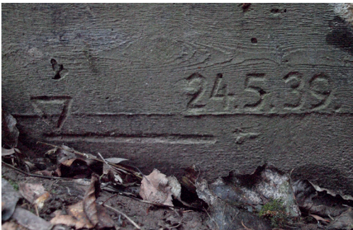
Abb. 17: Mit jeder Bunkerbeseitigung gehen auch kleine Details wie diese Hochwassermarke vom 24.05.1939 verloren. So hoch stand damals der Rhein und machte den Bunker für einige Zeit unbrauchbar. Foto: Thomas Eck.
