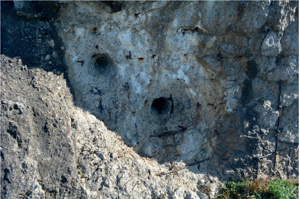
Abb. 10: Bereits 1939/40 erkannt, deckte der Beschuss der über den Rhein hinweg gut sichtbaren Bunker deren Schwächen erneut auf. In dieser Frontwand eines Rheinuferbunkers erzielten die Kanonen alliierter Panzer einen Durchschlag. Foto: Friedrich Wein.
