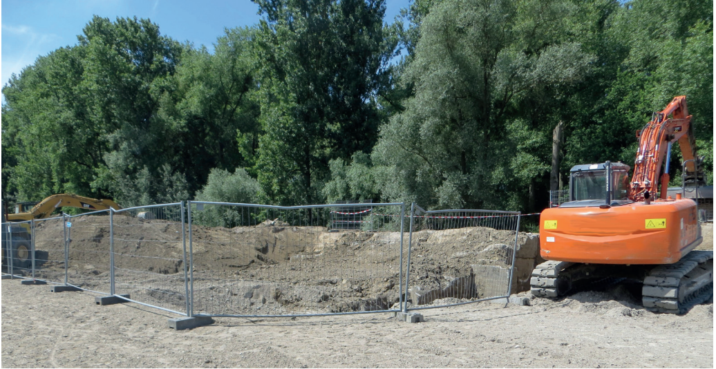
Abb. 19: Umfangreiche Dammsanierungen fordern ihren Tribut von den Westwall-Bunkern. An keinem Dammbau blieben die Bunker bislang bestehen, sie wurden alle entfernt. Foto: Günther Blödt.
