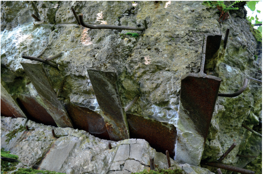
Abb. 12: Solche Stahlträger waren als Deckenträger und verlorene Schalung in den Bunkern eingebaut. Foto: Friedrich Wein.
