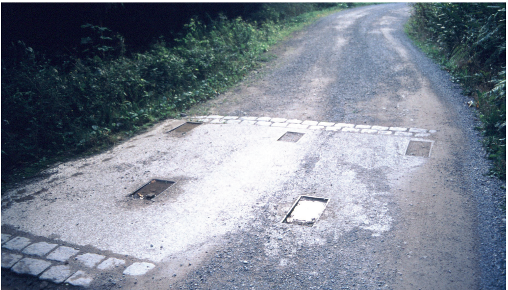
Abb. 3: Mit solchen bodenebenen Steckschiensperren wurden die Wege und Straßen, die von Westen her durch die Sperrstellen am westlichen Schwarzwaldrand hindurchführten, ausgestattet. Sie konnten im Bedarfsfall mit H-Profil-Trägern ausgestattet werden, die die Straße wirkungsvoll gegen Fahrzeuge und leichte Panzer sperren konnten. Foto: Friedrich Wein.
