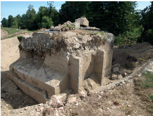
Abb. 16: Ein in Baden-Württemberg seltener Regelbau 23 wurde erst im Jahr 2015 im Rahmen des IRP am Oberrhein beseitigt. Geschah dies früher ohne jegliche Dokumentation, kann diese inzwischen in den meisten Fällen durchgeführt werden. Foto: Michael Truttenbach.
