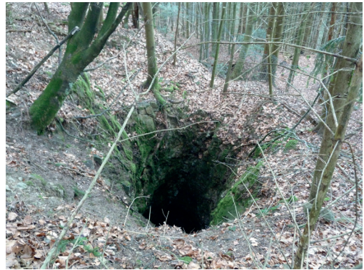
Abb. 40: Offener, ca. 30 m tiefer Bergbauschacht am Birkenberg bei St. Ulrich. Auch er dürfte aus dem 13./14. Jahrhundert stammen und diente der Förderung silberhaltiger Erze aus den zahlreichen schmalen Quarzgängen des Reviers. Die meisten Tagschächte aus dieser Zeit sind im Schwarzwald und Odenwald verfüllt oder verbrochen, oft künden nur noch Geländemulden (Pingen) von ihrer früheren Existenz. Foto: Wolfgang Werner, LGRB.
