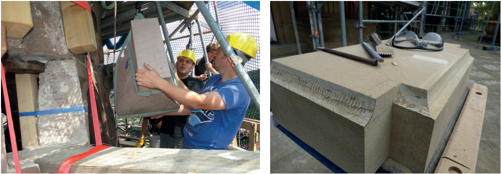
Abb. 30: Heimische Naturwerksteine kommen derzeit vor allem bei Renovierungsarbeiten an Baudenkmalen zum Einsatz, obgleich Qualität und Lagerstättengröße auch eine verstärkte Nutzung in der modernen Architektur zulassen würden: (A) Einbau eines neuen Ecksteins aus Neckartäler Buntsandstein an der Turmpyramide des Freiburger Münsters im Jahr 2013. Foto: Münsterbauverein Freiburg. (B) In Bearbeitung befindliches Werkstück von Güglinger Schilfsandstein vor der Villa Reitzenstein, dem Sitz des baden-württembergischen Ministerpräsidenten. Im Hintergrund sind die Baugerüste zu erkennen, welche zur Durchführung der Renovierungsmaßnahmen unter Verwendung heimischer Naturwerksteine errichtet wurden. Foto: Birgit Kimmig, LGRB, 2014.
