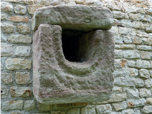
Abb. 44: Abflusssrinne an der Nordmauer des römischen Badegebäudes von Badenweiler. Für das Abflusssystem, durch das das warme, durch Badezusätze basische Wasser abgeleitet wurde, verwendete man gezielt Werksteine aus verkieseltem Sandstein. Das Foto zeigt ein Werkstück aus Degerfelder Sandstein, ein stark verkieselter (= durch Quarz gebundener) Quarzsandstein des Buntsandsteins vom Hochrhein. Foto: Wolfgang Werner, LGRB.
