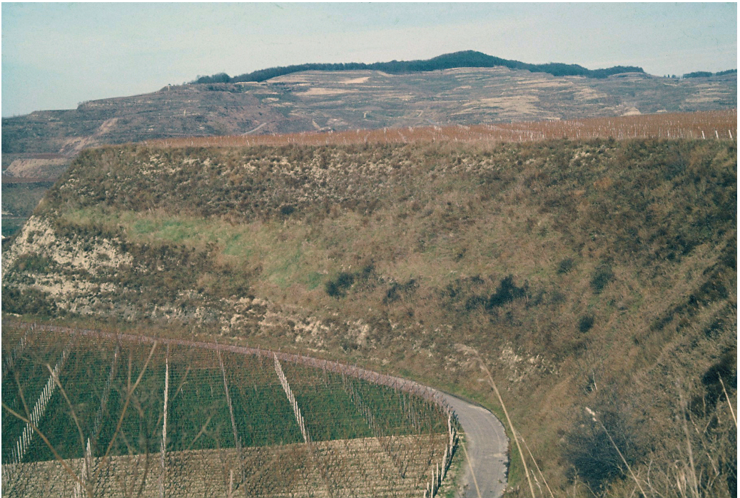
Abb. 20: Diese Böschung ist rund 10 Jahre alt; ins Auge springen drei vom Ausgangssubstrat bestimmte Streifen mit farblich, also auch floristisch verschiedenem Bewuchs. Foto: O. W., 2.12.1979.
