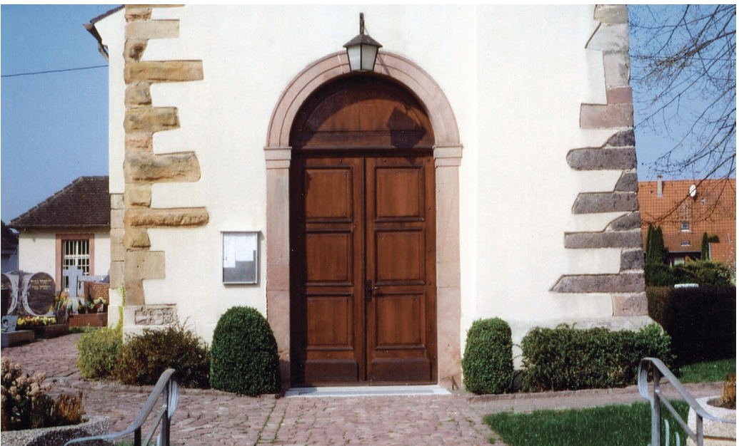
Abb. 18: Die Kirche in Baltzenheim (Elsass) mit dunklen Quadern aus Tephrit-Pyroklastit an der rechten Kante des Turmes. Foto: W. W.
