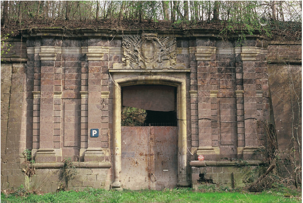
Abb. 8: Das Fort Mortier auf der linken Rheinseite. Mauerwerk größtenteils aus Tephrit-Pyroklastit, teilweise auch aus Buntsandstein, Relief und helle Gesimse aus Kalkstein. Foto: W. W.
