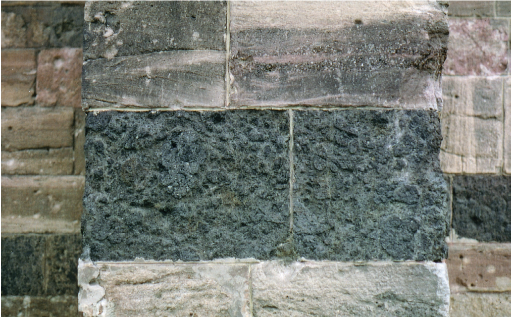
Abb. 4: Detail von der Vorderseite des in Abb. 3 rechts gezeigten Pfeilers; Quader aus dunklem Tephrit-Agglomerat. Objektbreite vorn 1,2 m. Foto: W. W.
