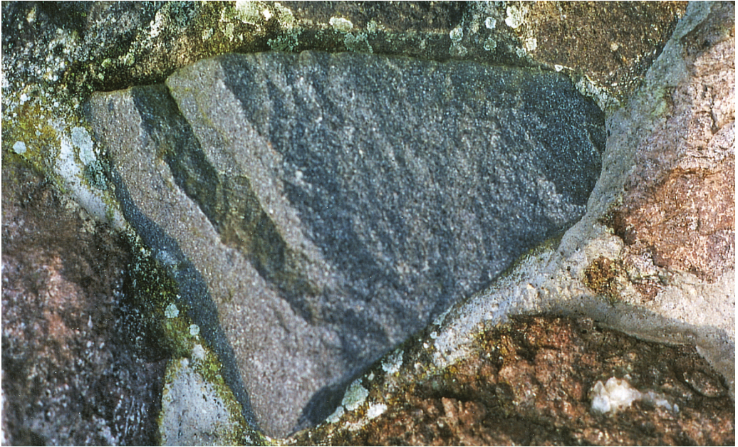
Abb. 12: Etwa 0,4 m breites Bruchstück von Gangtephrit aus der Umgebung von Endingen als Baustein der mittelalterlichen Stadtmauer. Foto: W. W.
