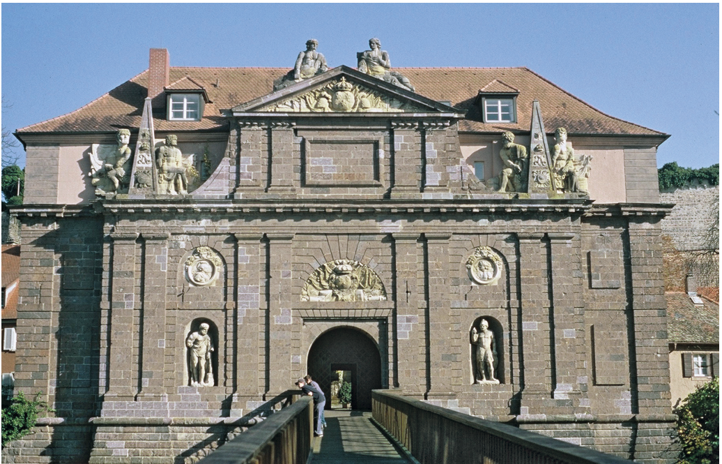
Abb. 7: Das Rheintor in Breisach. Mauerwerk aus Tephrit-Pyroklastit, Figuren und Reliefs aus Kalkstein. Foto: W. W.
