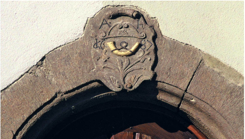
Abb. 9: Türrahmen des ehemaligen Postgebäudes in Burkheim. Relief aus Tephrit-Aschentuff. Objektbreite etwa 1,5 m. Foto: W. W.
