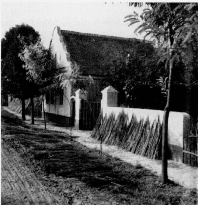
Lehmgestampftes und schilfgedecktes Bauernhaus in Hodschag aus der frühen Ansiedlungszeit Repro: Gerhard Finkbeiner
