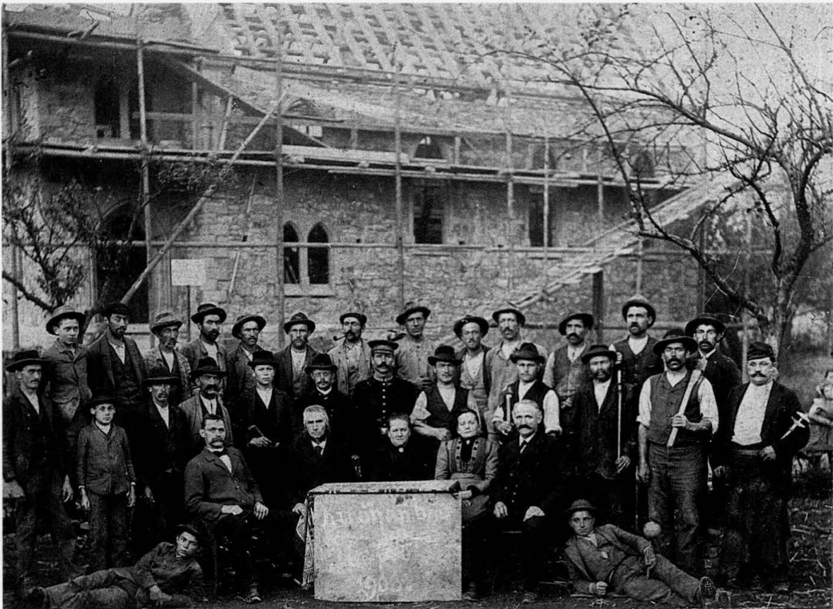
Noch im Spätherbst des Jahres 1903 konnte das Richtfest am Bau der neuen evangelischen Kirche in Hausach gefeiert werden.
