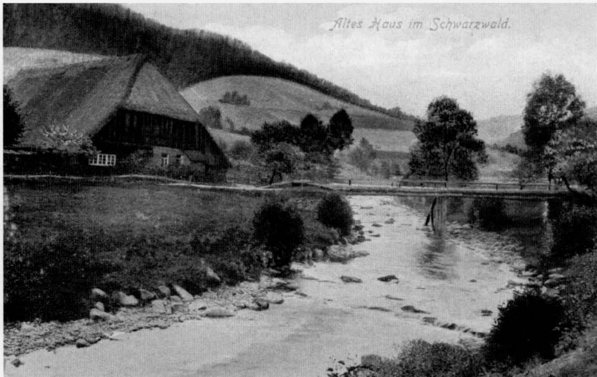
Bild 5: Der Jungbauernhof in Oberwolfach-Walke um 1900, ein eingeschossiges Kinzigtäler Haus ohne steinernes Sockelgeschoss. Das Vieh dieses Hofes steht im Stall hinter dem Wohnteil des Hauses, nicht wie bei Kinzigtäler Häusern allgemein üblich im steinernen Sockelgeschoss. Ein Stein im Kachelofen trägt die Zahl 1697; sie kann, muss aber nicht identisch mit dem Baujahr des Hauses sein.
