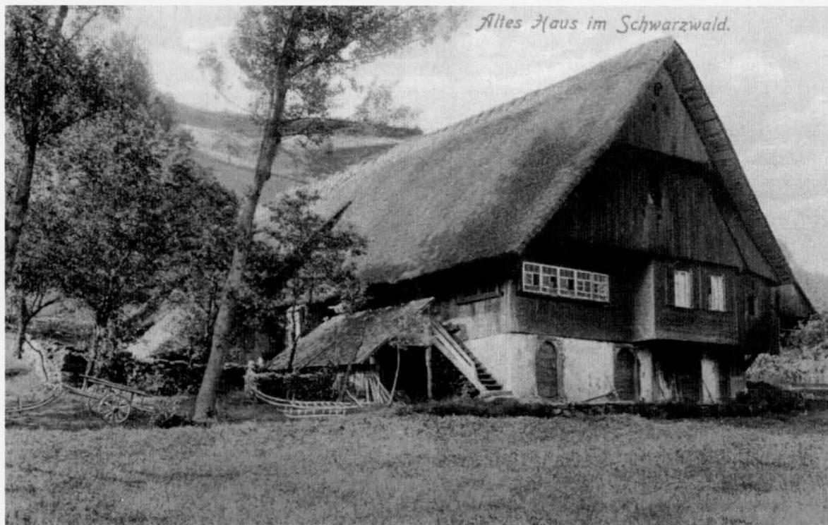
Bild 9: Ein eingeschossiges Kinzigtäler Haus mit dreieckigem Giebfeld: der Zangershof in Oberwolfach-Obertal um 1900. Zwischenzeitlich wurde das Strohdach durch ein Tonziegeldach und das ursprüngliche dreieckige Giebfeld durch einen Walm ersetzt.
