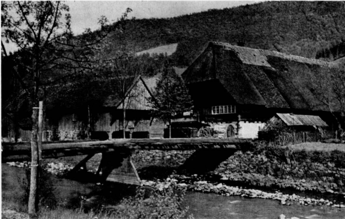
Bild 13: Der um 1607/08 in Oberwolfach-Walke „am Wasser“ erbaute Lorenzenhof an seinem ursprünglichen Standort um 1910 – heute im Schwarzwälder Freilichtmuseum „Vogtsbauernhof“ in Gutach.
