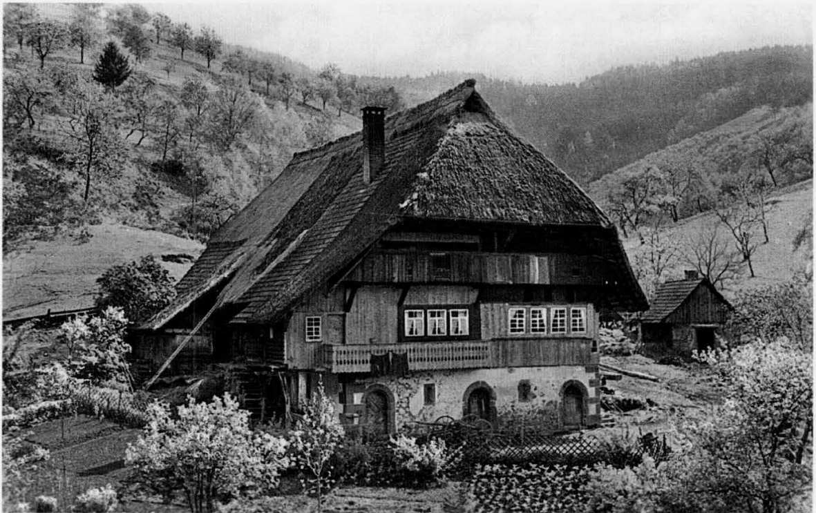
Bild 2: Ein typisches eingeschossiges Kinzigtäler Haus: der 1588 erbaute Jockelehof in Wolfach-Kirnbach um 1920. Der Hauptzugang zum Wohnteil befindet sich an der rechten Traufseite des Gebäudes. Im steinernen Sockelgeschoss ist das Vieh untergebracht; die Türen rechts und links führen zu den Stallgängen, die mittlere erschließt den Futtergang. Die Raumfolge im darüber angeordneten hölzernen Wohngeschoss von rechts nach links: die Wohnstube, die Schlafkammer des Bauernpaares mit vorgebautem Kammertrippel und ein später angebauter, über das Sockelgeschoss hinausragender Gebäudeteil. Darüber das Dachgeschoss mit ebenfalls vorgebautem Trippel.
