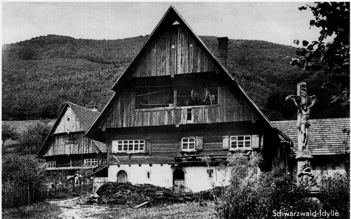
Bild 10: Der 1764 erbaute Busamhof mit „Nebenhaus“ in Lautenbach/Sulzbach um 1920, ein eingeschossiges Kinzigtäler Haus mit dem so genannten „Renchtäler Giebel“. Das Kreuz wurde im Jahre 1812 errichtet.
