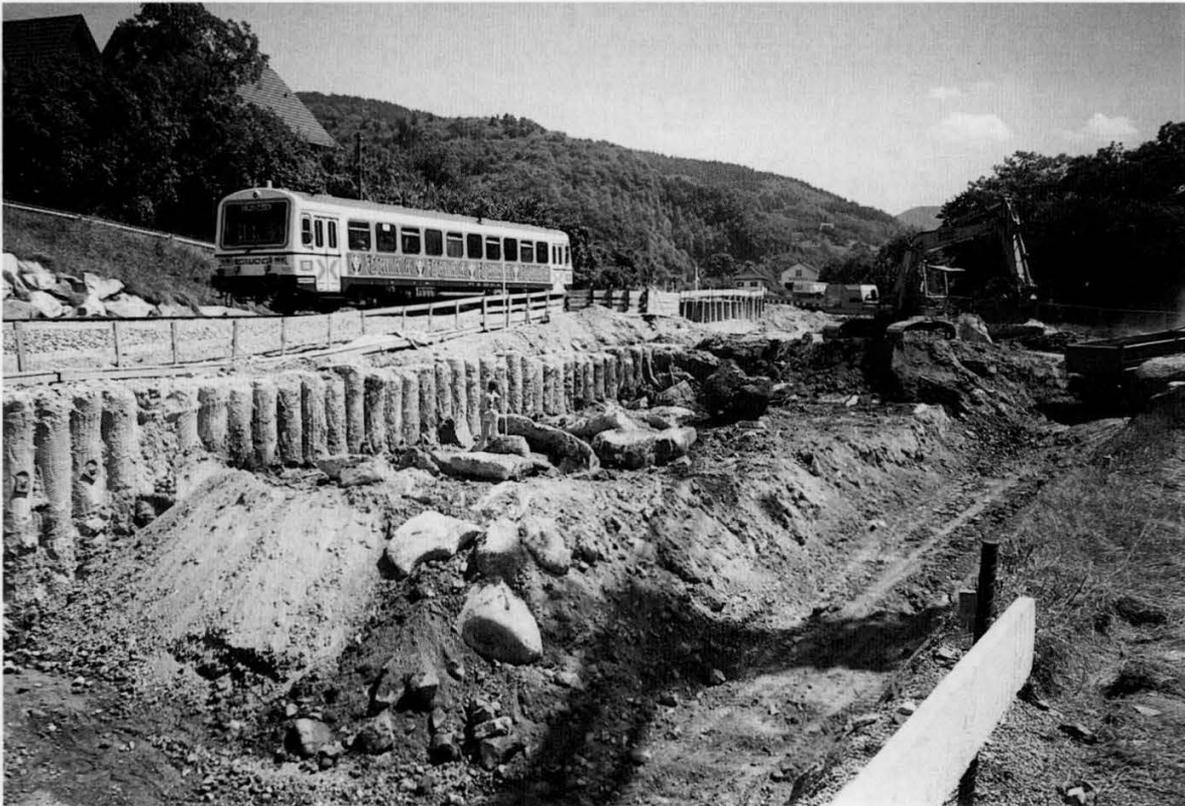
Abb. 7: Trogbauwerk Kappelrodeck-Furschenbach (Ortsumgehung Kappelrodeck) im Achertal (Nord-Schwarzwald) mit eingebrachter Betonschlitzwand der Nordseite und zahlreichen kantengerundeten Erratikas (Findlinge bis 150 t Gewicht) in einer 8 m mächtigen, im ganzen Achertal verbreiteten Grundmoräne (130–330 m NN). Untergrund: grobkörniger Achertalgranit (220 m NN).
