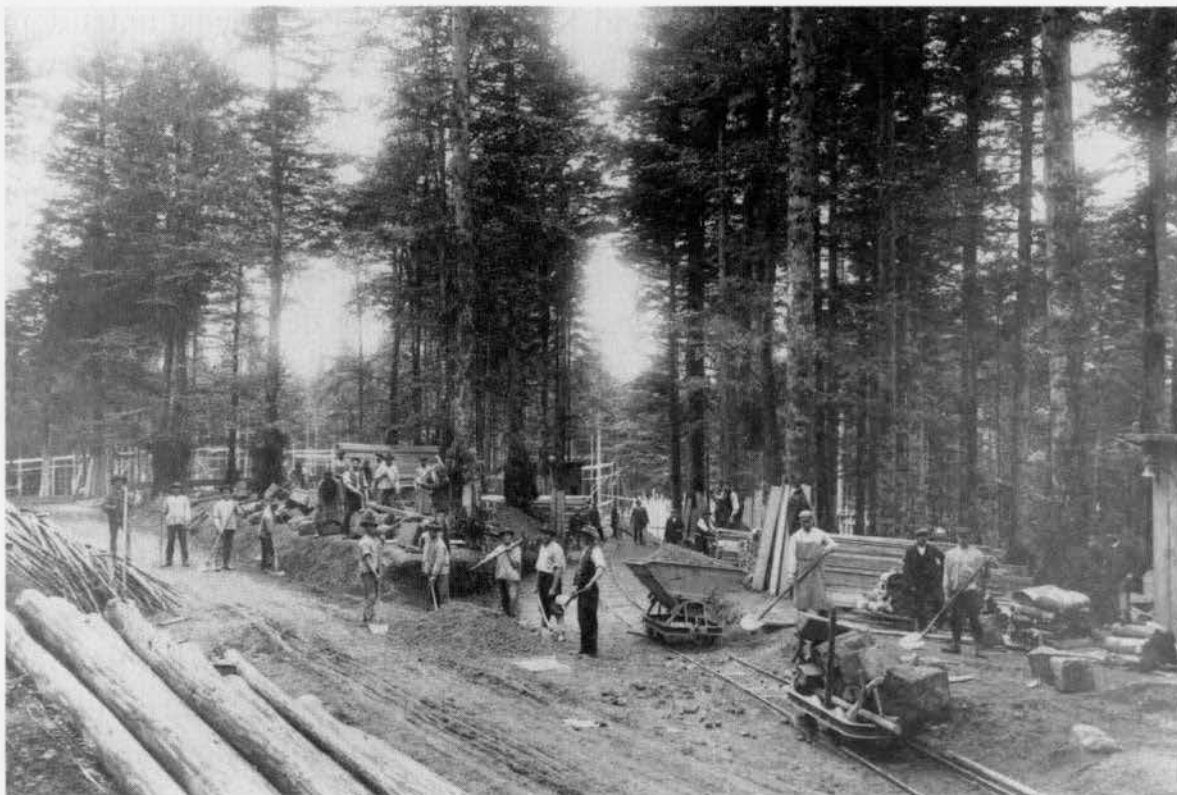
Bauarbeiten am Offiziersgenesungsheim Bühlerhöhe. Das Foto entstand in den Jahren 1912 bis 1914 Foto: Stadtgeschichtliches Institut Bühl
