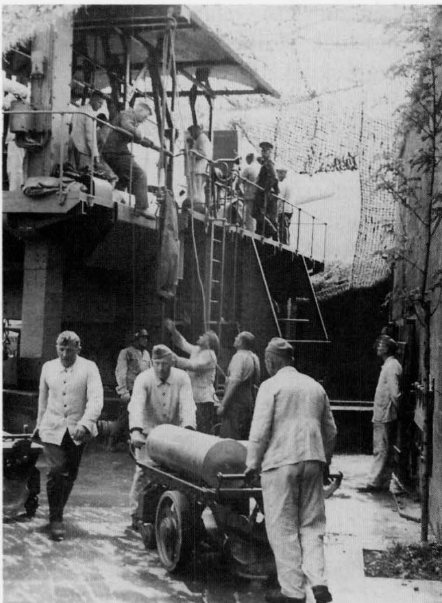
Transport von Kartusche und Geschoss vom Munitionsbunker zum Aufzug bei der Geschütz- anlage Abb.: Käshammer
