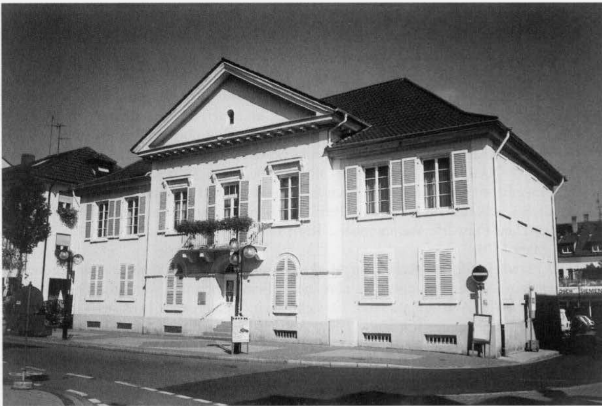
Abb. 16: Das sog. „Weinbrenner-Haus“ in der Hauptstraße, Aufn. d. Verf.
