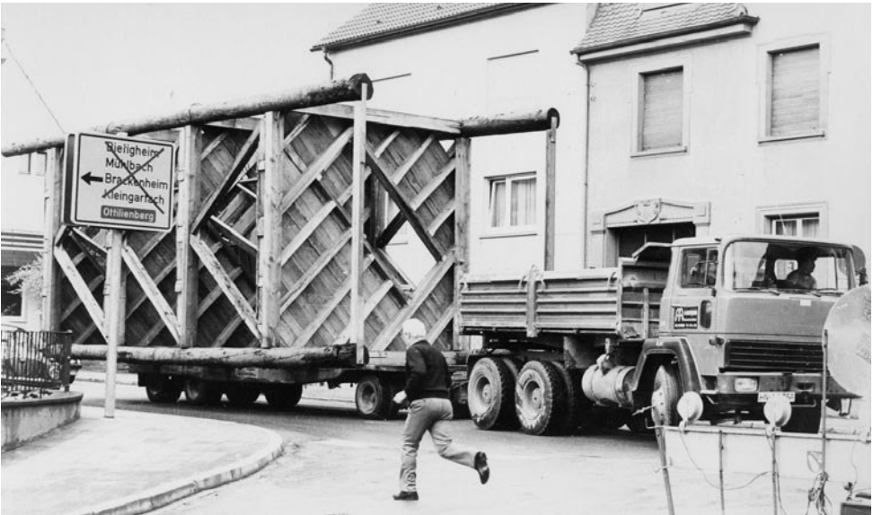
Transport des Turmgerüsts von der Halle der Fa. Mack zum späteren Standort
