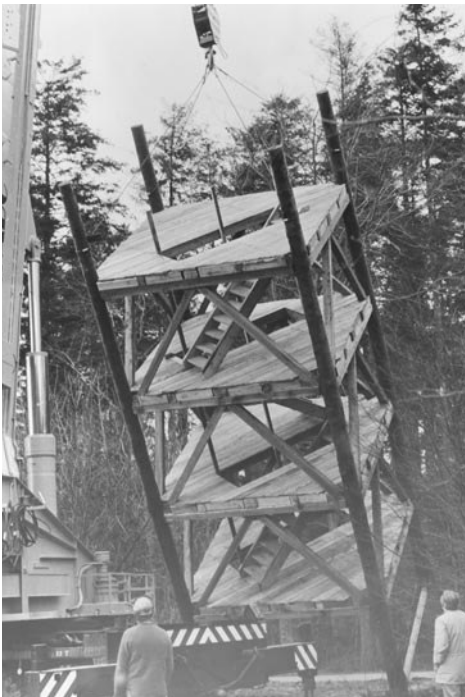
Aufstellen des Turms mit Hilfe eines Kranwagens
