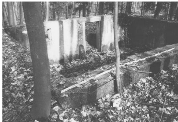
Die heute noch im Birkenwald sichtbare Unterkellerung
