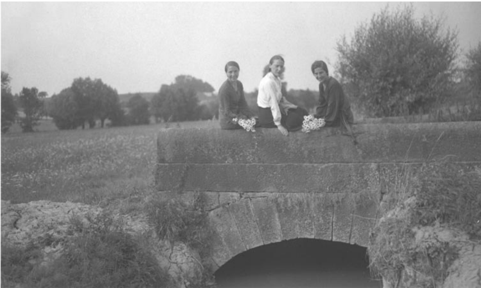
Steinerne Brücke über den Mühlkanal vor dem Abriss
