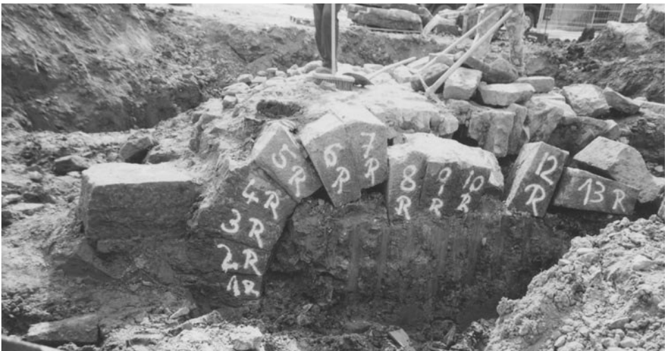
Die Brücke war ein Kleindenkmal mit eigener Nummer und eingetragen in der Liste der geschützten Kulturdenkmäler.
