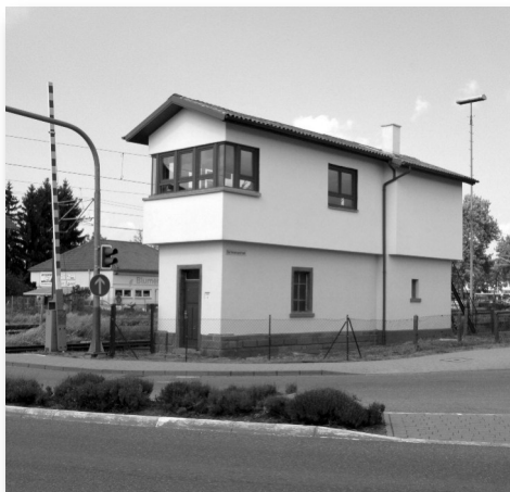
Das Stellwerk Eppingen „West“ nach der Renovierung durch die Stadt Eppingen.
