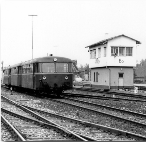
Das ehemalige Eppinger Stellwerk „Ost“ in Höhe des Getreidelagerhauses. Es wurde im Jahr 2012 abgerissen.
