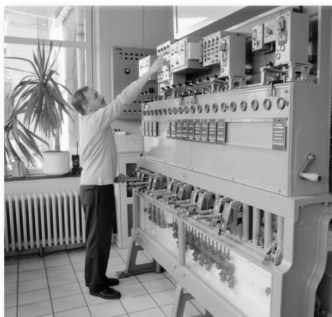
Blick in das Befehlsstellwerk im Eppinger Bahnhof.
