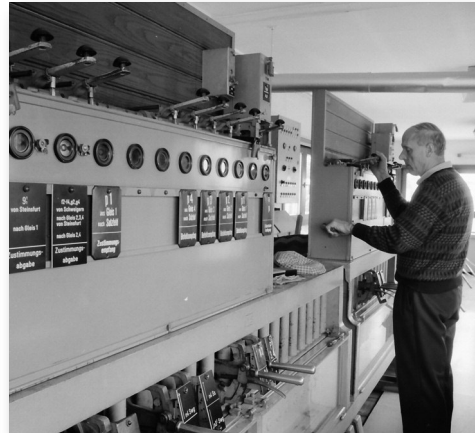
Der Bahnhofsblock am Stellwerk „West“ in Eppingen.
