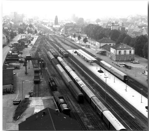
Blick vom Eppinger Getreidesilo auf den westlichen Bahnhofsbereich, für den das Stellwerk „West“ zuständig war. Um die Anzahl der Schrankenschließungen zu vermindern, sollte der Rangierbetrieb in den östlichen Bahnhofsbereich verlagert werden.
