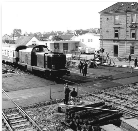
Blick auf den Bahnübergang beim Stellwerk „Eppingen West“. Im Oktober 1983 wurde er grundlegend saniert.
