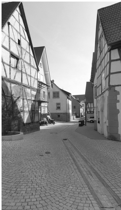
Die Leiergasse nach ihrer Sanierung 2016
