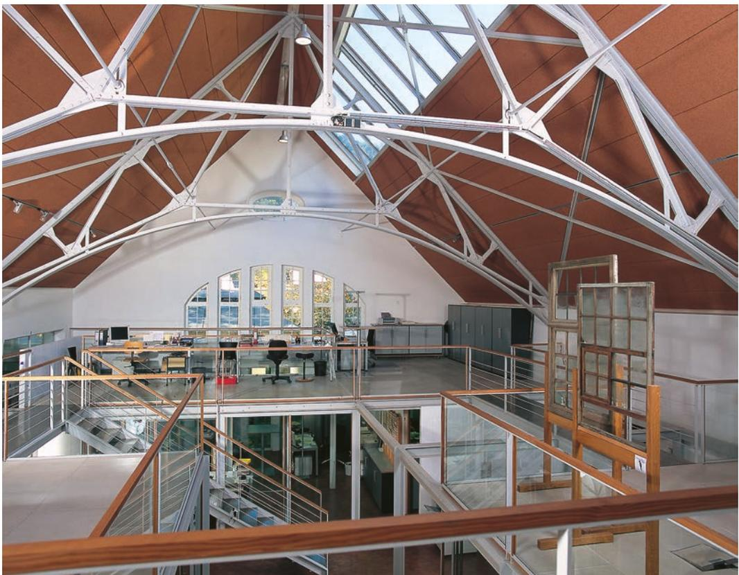
*Der ehemalige Speisesaal der Arbeiterkantine mit eiserner Dachkonstruktion von 1909. Die neuen Einbauten für Büros und Ausstellung bestechen durch ihre Leichtigkeit.*
