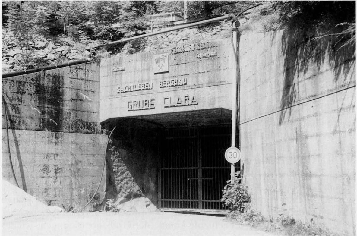
Abb. 9: Neuer Einfahrtstollen der Grube Clara in Oberwolfach
