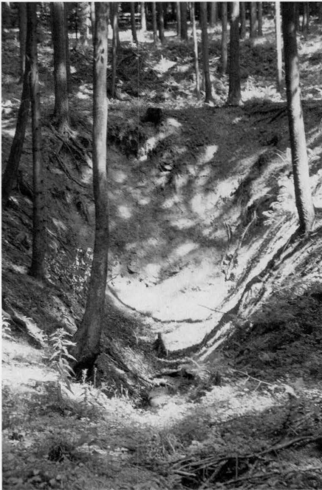
Abb. 11: Verfallenes Stollenmundloch der Grube Ludwig im Adlersbach
