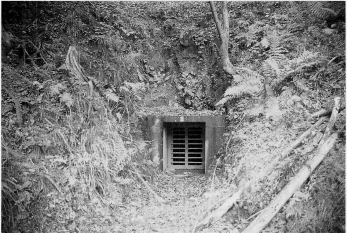
Abb. 2: Vergittertes Stollenmundloch des mittleren Wolfgangstollens in Alpirsbach
