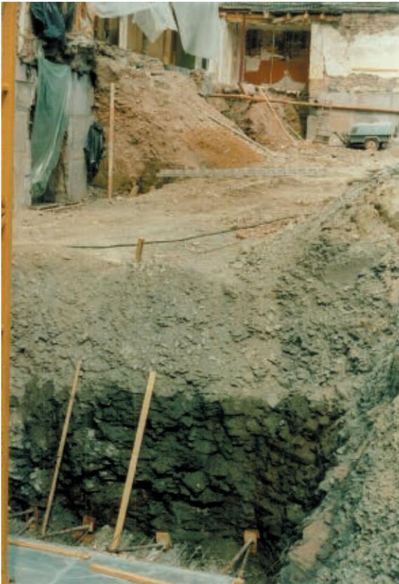
Abb. 13 – Unterhalb der Geröll- und Lehmzone der alten Brigach-Flussrinne tritt punktuell im kompaktfelsigen Teil des Unteren Muschelkalks Kluftgrundwasser aus und verfärbt den grauen Stein oberflächlich ins Blaugraue. Die tiefliegende Kluftgrundwasserleitung erklärt sich aus der Infiltration durch die Brigach. (Im Bild: Baugrube Franziskanerhotel, 1989)
