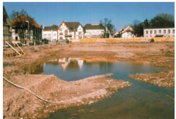
Abb. 12 – Beim Aushub der Garage Neue Tonhalle wurde der Grundwasserspiegel über der verschlossenen Lehmschicht sichtbar, die für den schwankenden Wasserstand in der aufgeschotterten alten Flussrinne der Brigach verantwortlich ist.
