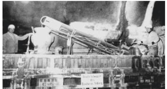
Abb. 4 Abdichtungsarbeiten an den Tunnelgewölben.
