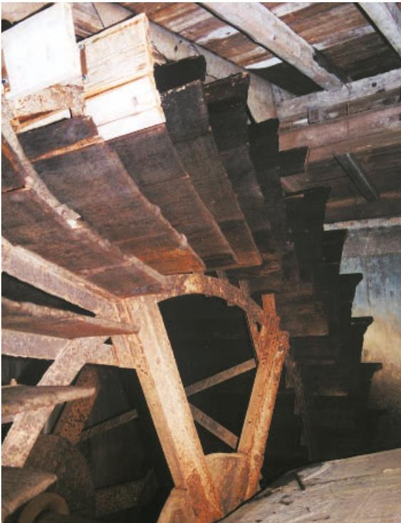
*Das alte Mühlrad hat nicht ausgedient. Mit seinen breiten Schaufeln wird es vom Wasser eines Seitenkanals der Brigach angetrieben und ist mit der Stromversorgung der Mühle gekoppelt.*
