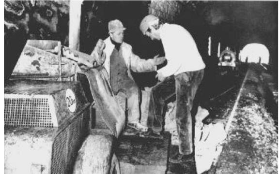
Abb. 5 Mischmaschine für die Zementinjektionen.
