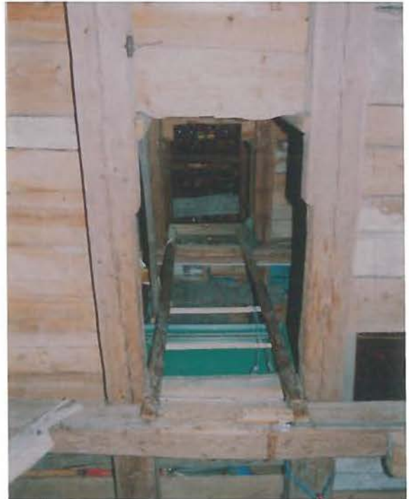
Scheuer Goldgrubengasse 23. Im Mittelteil über dem Erdgeschoss in der Holzdecke die Öffnung in den Heuaufzugsschacht. Noch gibt es einige Exemplare in alten Gebäuden.
