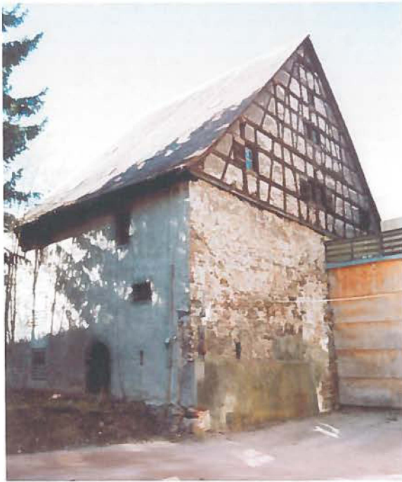
Scheuer, Bickenstr. 6, Rückgebäude Wiebelt
