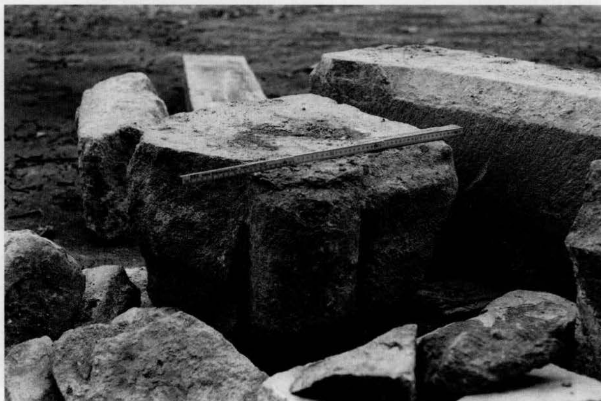
Abb. 6: Einer der beiden gotischen Podeststeinblöcke (auf dem Kopf lagernd) mit Führungspfanne für den Torflügel
