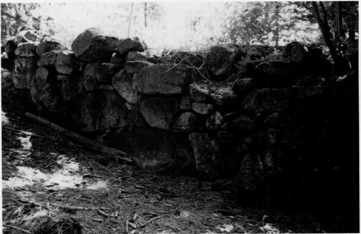
Abb. 32: Mächtige Steinmauer aus Granit von einem Gebäude an der sogenannten „Römerstraße“ im Schneckenloch/Schonach
