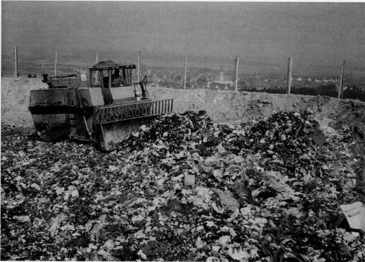
Abb. 8: Müllleinbau mit Compaktor
