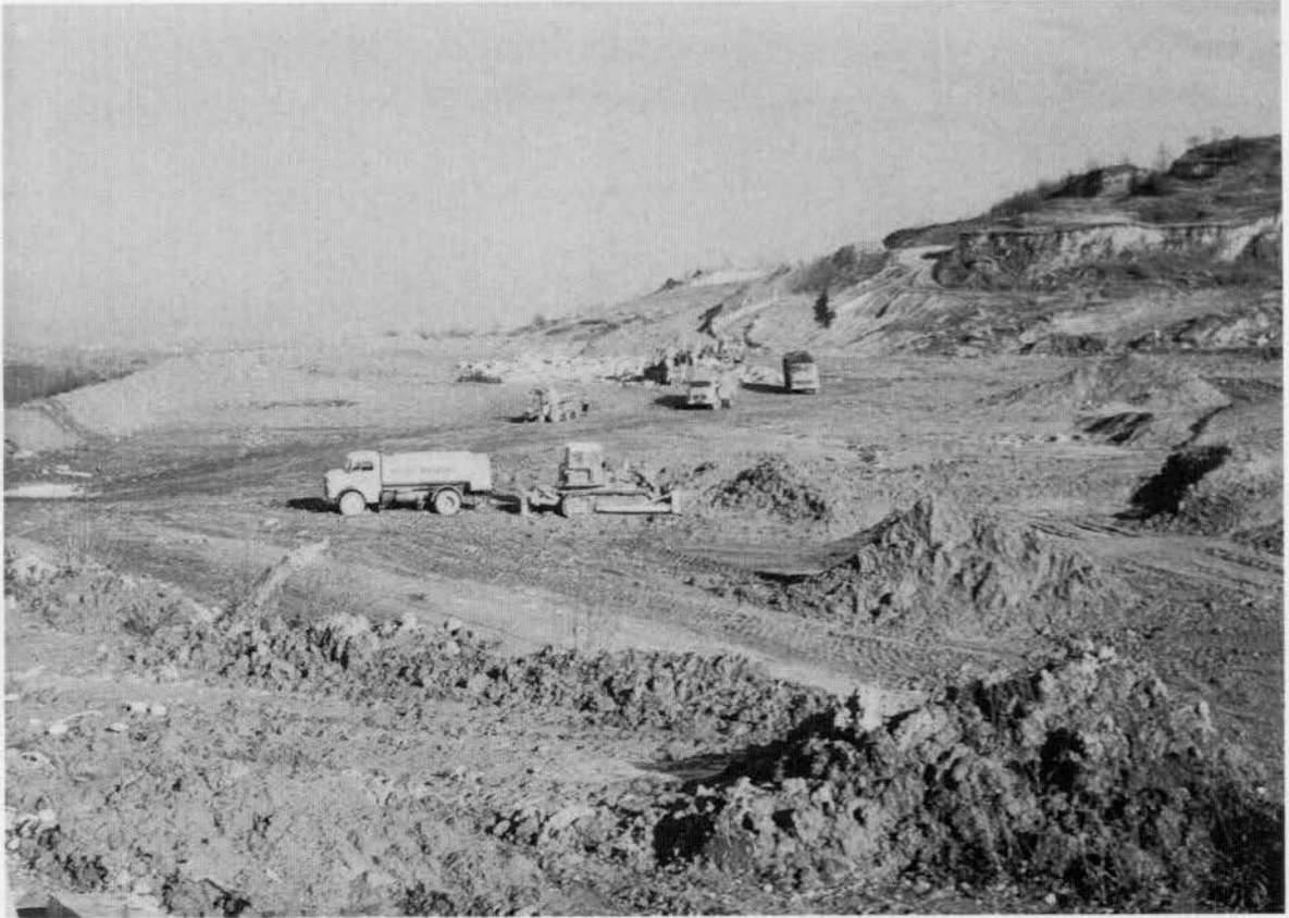
Abb. 9: Täglicher Müllplatz mit Erdaddeckung
