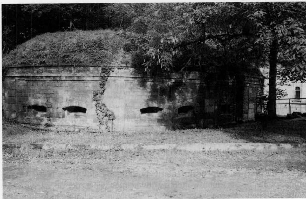
Abb. 3: Zum Vergleich: Blockhaus mit Betonverstärkung im Kehlaffenplatz von Fort Moltke, Straßburg
