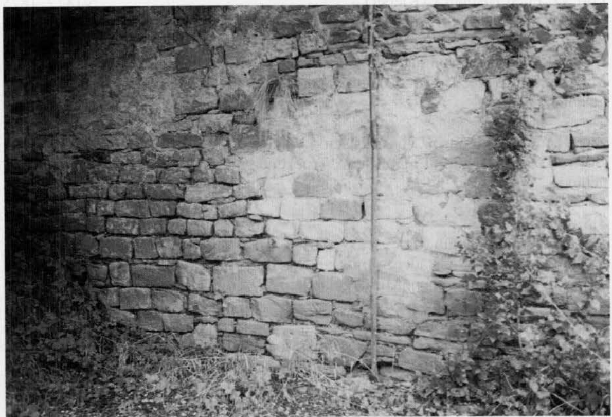
Abb. 7: Bruchsteinmauerteil von Fort Kirchbach
