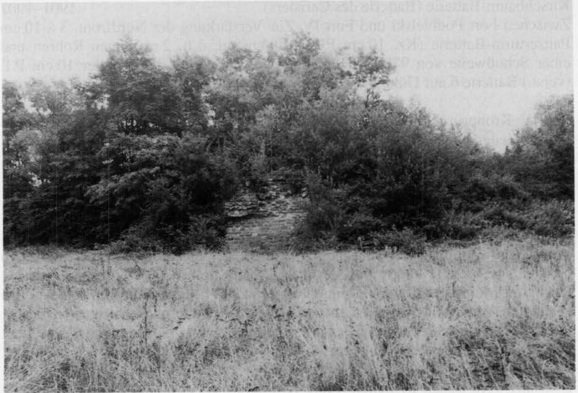
Abb. 6: Mauerrest von Fort Kirchbach
