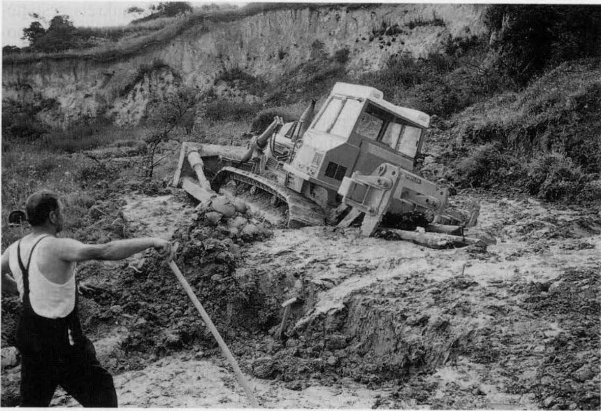
Abb. 7: Hangrutschung mit Schlammaustritt
