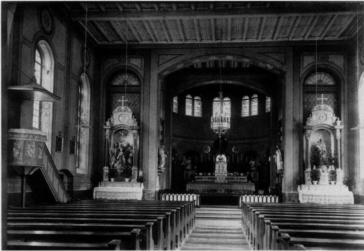
Pfarrkirche Honau, Innenansicht 1. vor der Innenrenovation von 1932
