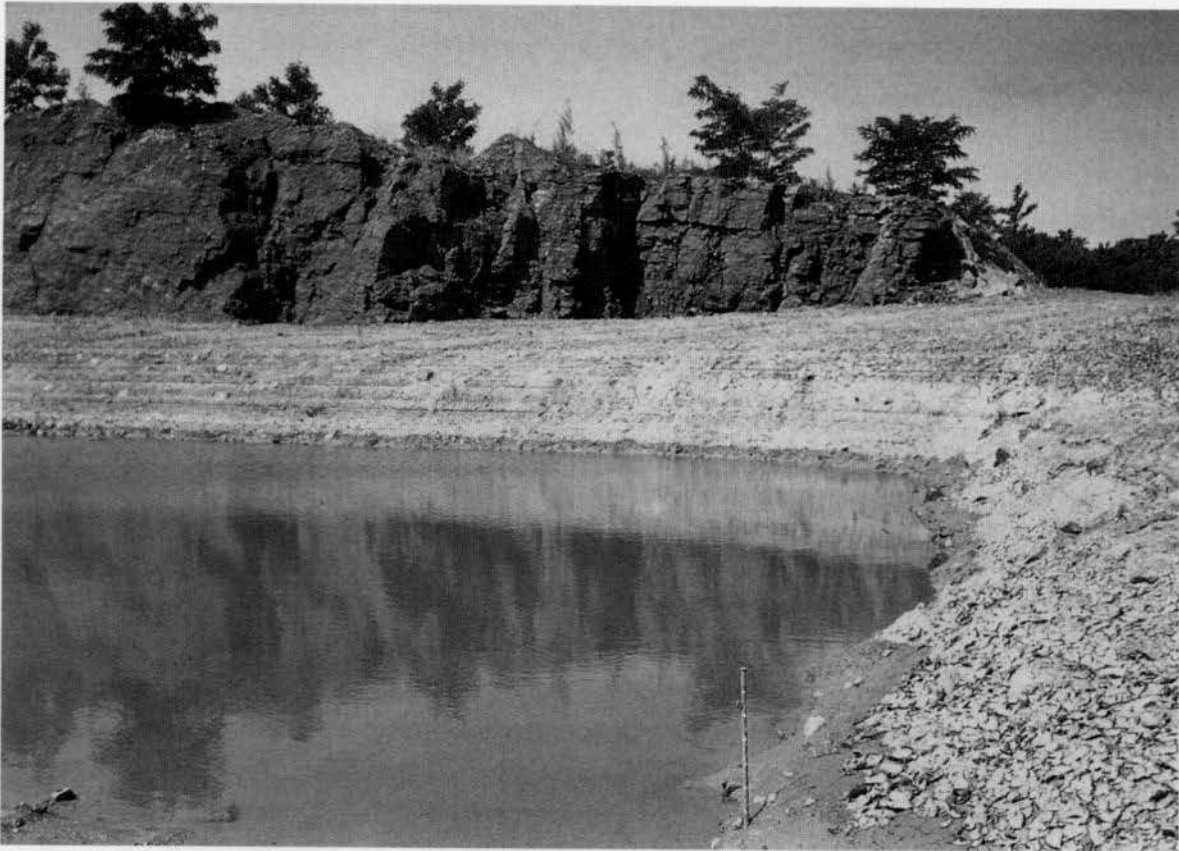
Abb. 10: Schlammfangbecken im Tagebautiefsten
