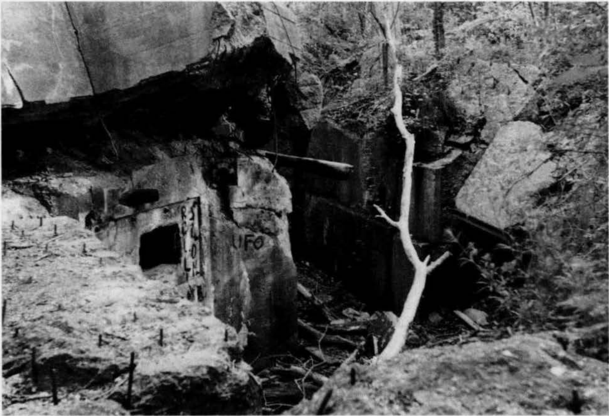
Rest eines Westwallbunkers beim Kehler Kulturwehr
