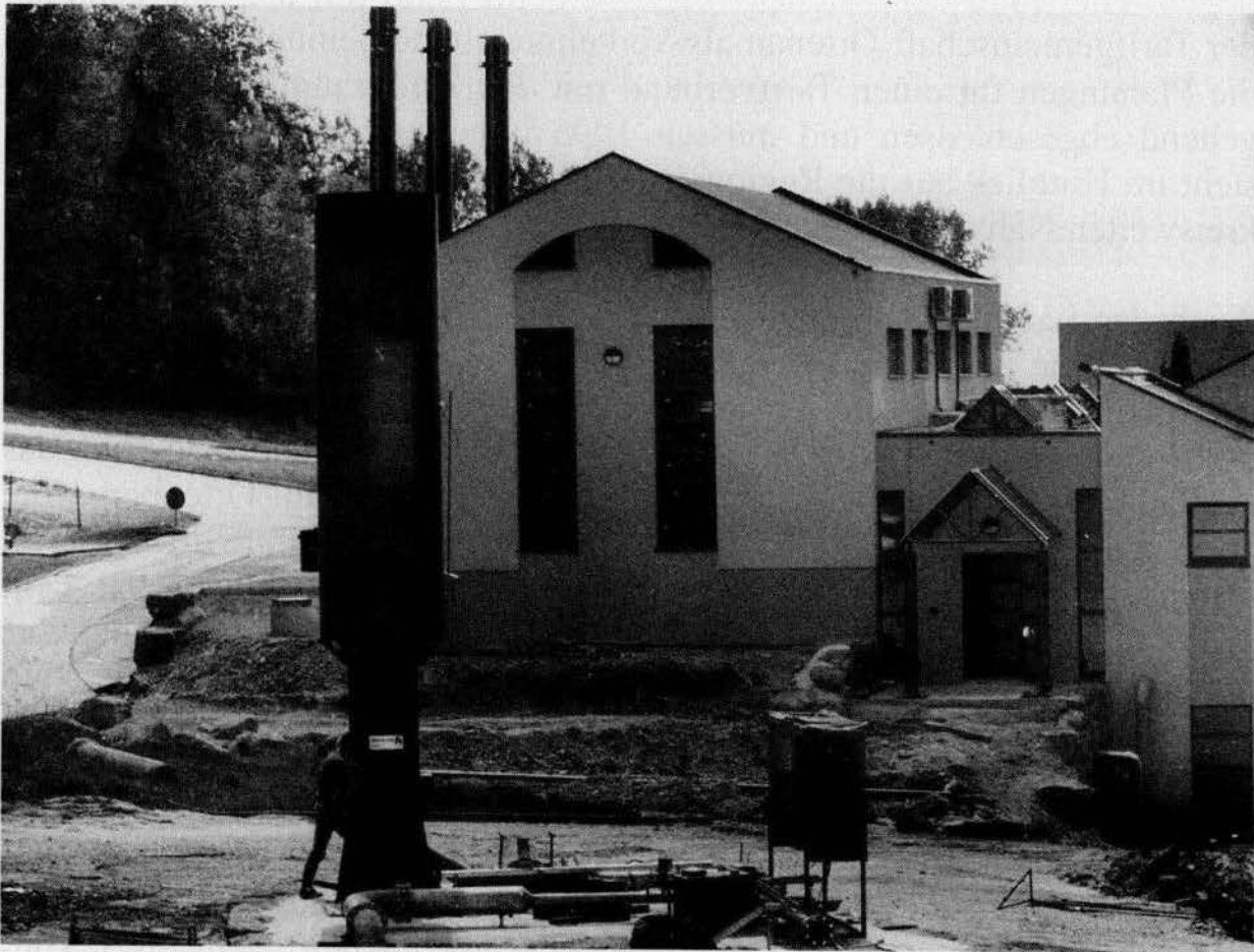
Umwandlung von Deponiegas in Energie: Die Gasverwertungsanlage auf dem Kahlenberg
