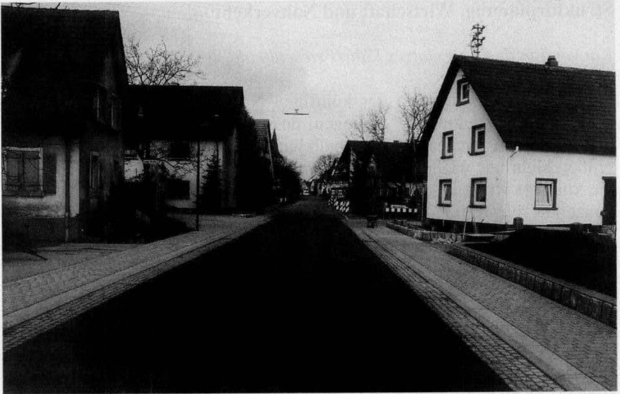
Die Ortsdurchfahrt in Achern-Gamshurst: am 15. Dezember 94 wurde der zweite Bauabschnitt offiziell abgenommen. Foto: ABB
