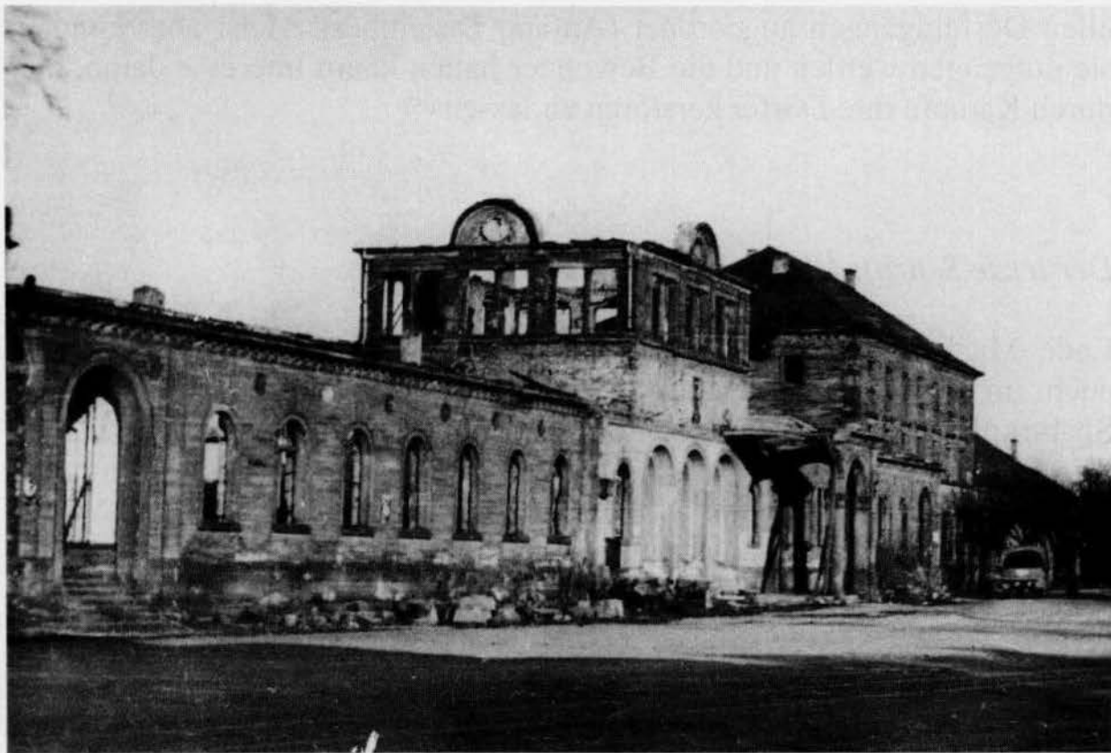
Der Kehler Bahnhof, zerschossen während der Zeit der Evakuierung zwischen November 1944 und April 1945 (Fotos: Steckner)
