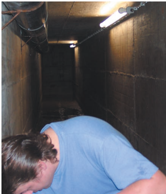
Im Schacht mit Blick zum Schachteingang.
