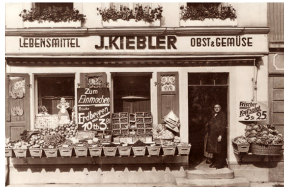
Abb. 2: 1931 blickt Johann Kiebler, nach dem Rechten auf der Niederen Straße
