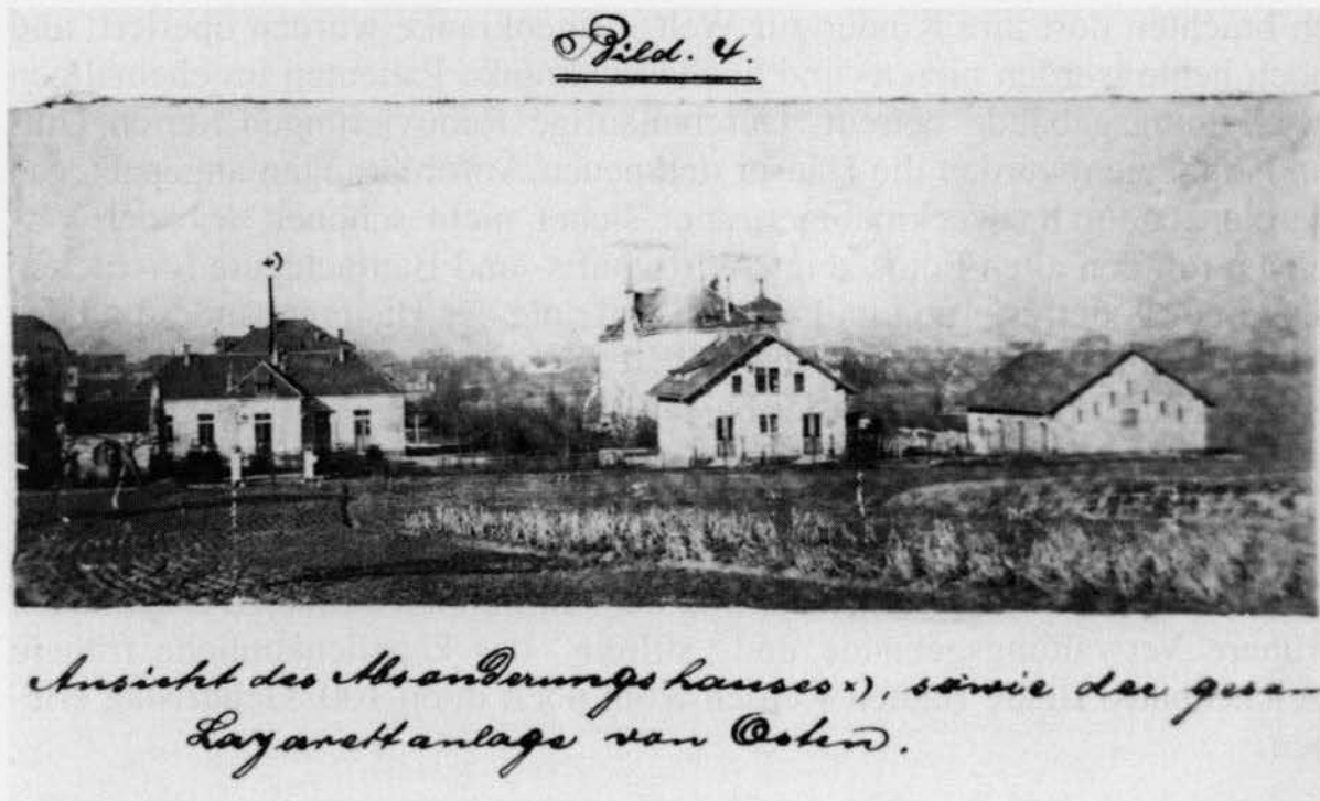
Abb. 7: Ansicht der gesamten Anlage von Osten
