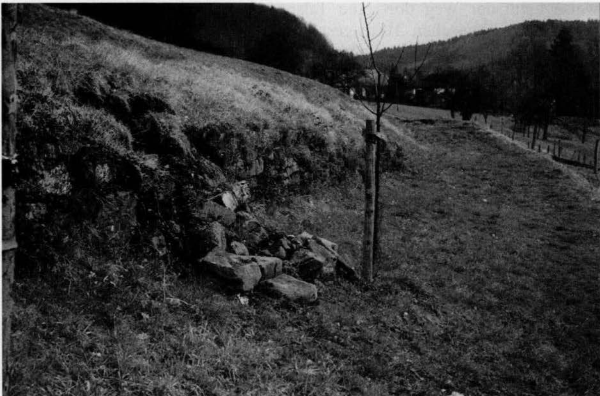
Reste der Stützmauer des mittelalterlichen Klosterwegs zwischen Münchweier und Ettenheimmünster.
