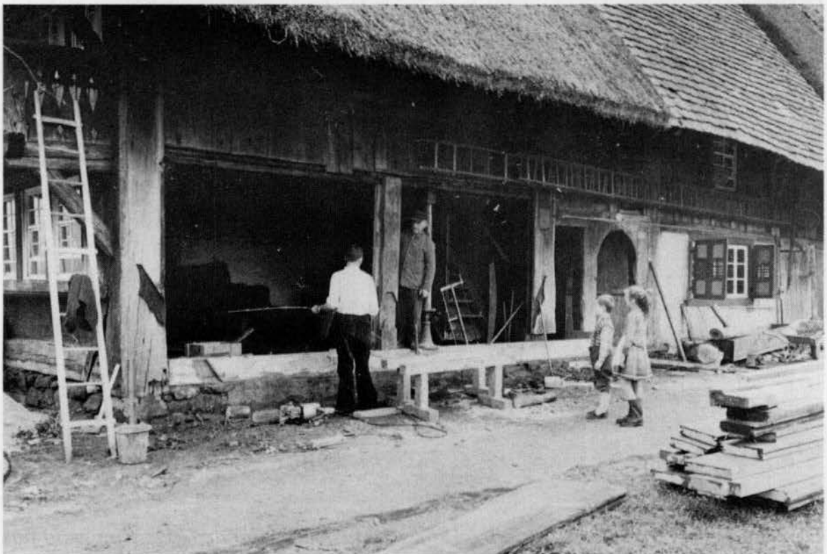
Vogtsbauernhof. Renovierung des Stubenbereichs im Jahre 1963 (v. l. Berthold Breithaupt. Museumsverwalter, und Jakob Blum).
