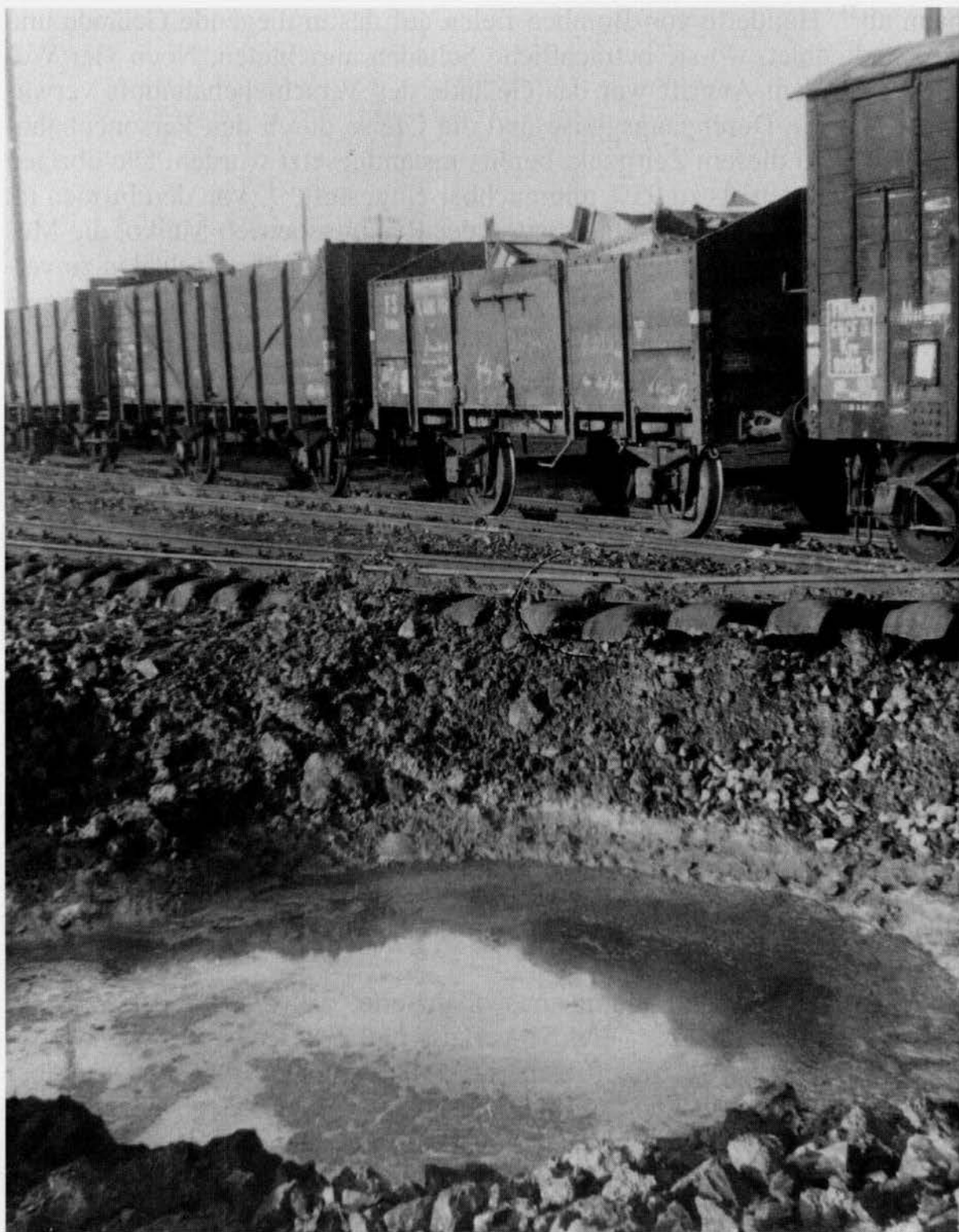
Zerstörungen durch Luftangriffe auf dem Offenburger Güterbahnhof 1944.
