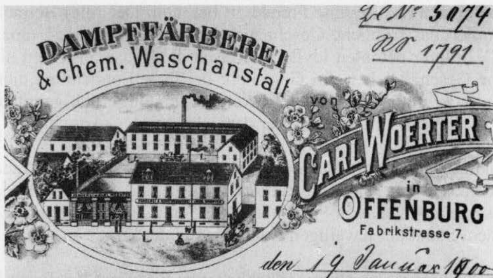
Bild 30: Dampfwäscherei und Chemische Waschanstalt Karl Wörter, Fabrikstraße 7
