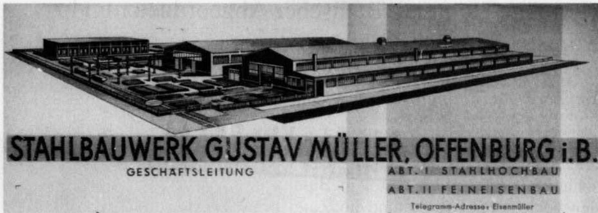
Bild 61: Stahlbauwerk Gustav Müller, Englerstraße 1
