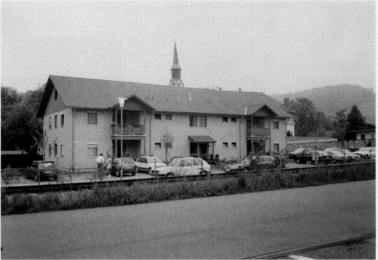
Übergangwohnheim in Zell a. H. (Fertigstellung im März 1991 mit 170 Plätzen).
