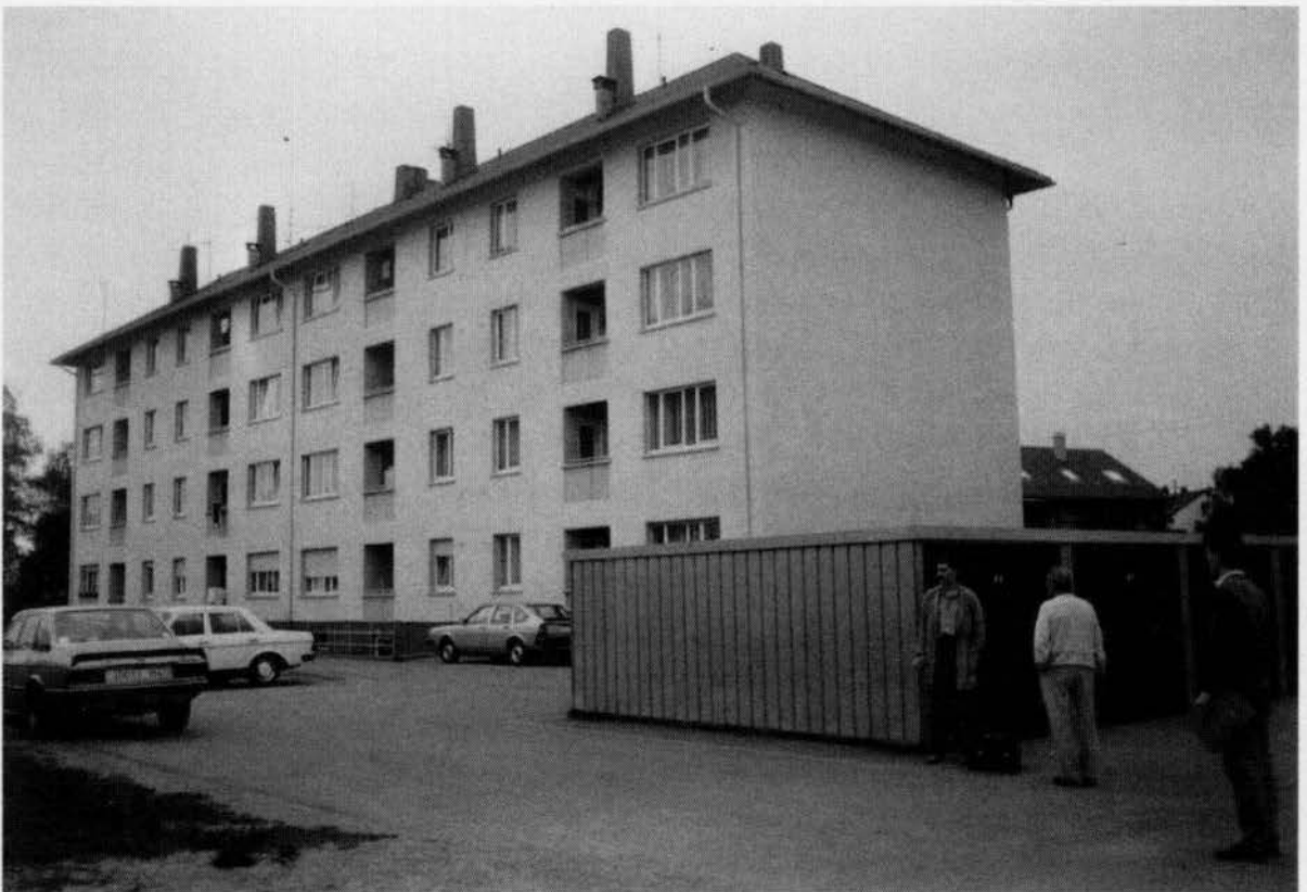
Ein Wohnblock des Staatl. Übergangwohnhauses Kehl mit insgesamt 660 Plätzen (Errichtung im Frühjahr 1992)
