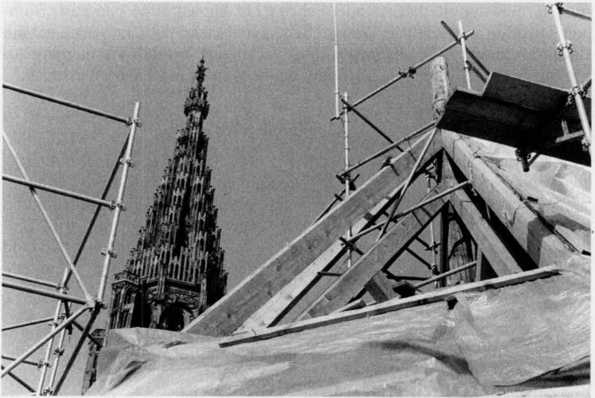
Der neue obere Teil des Dachstuhles mit der Münsterspitze., 1991
