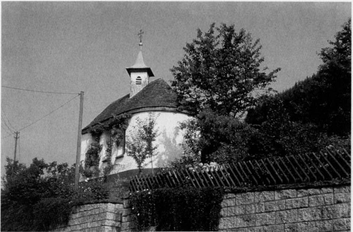
Sanierung Martinskapelle, Hausach
