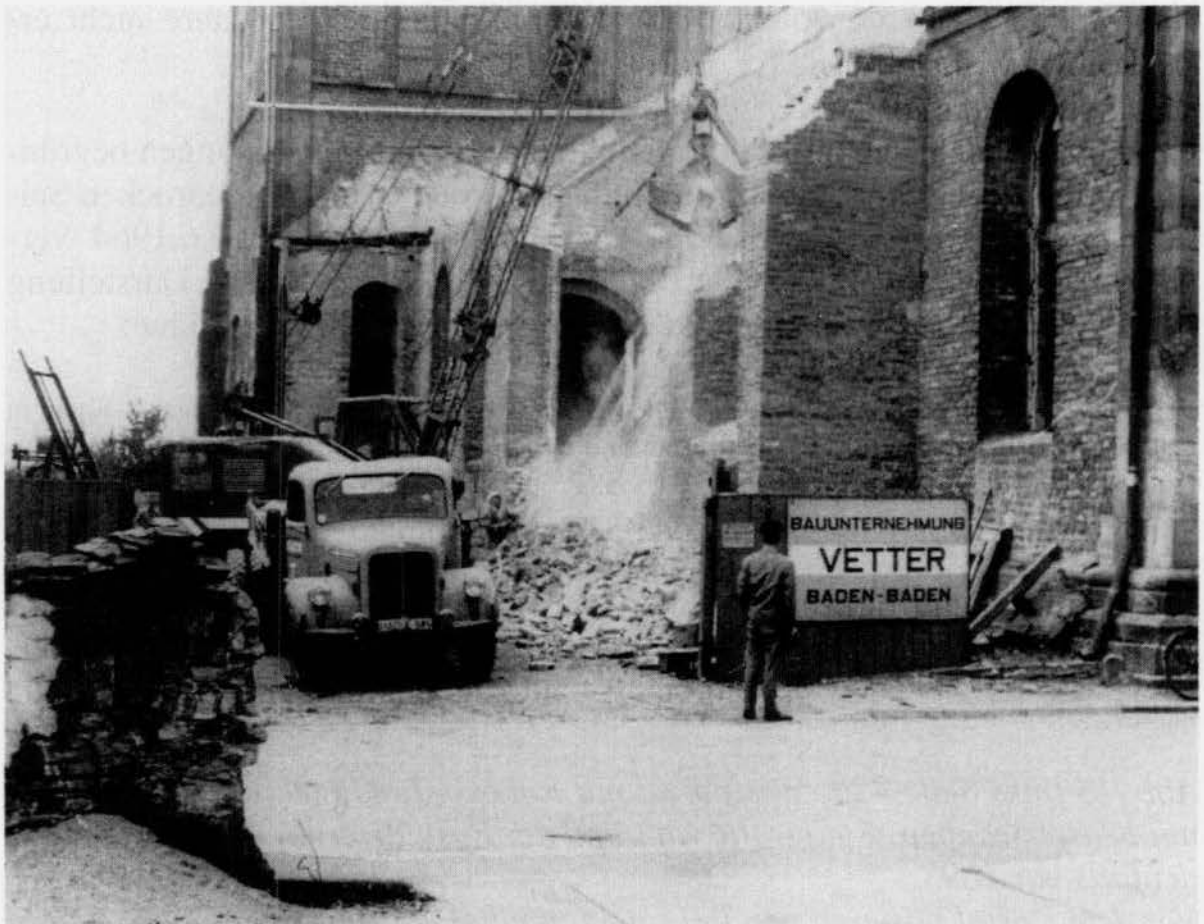
Abb. 14: Abbruch der barocken Seitenschiffe, 1967.
