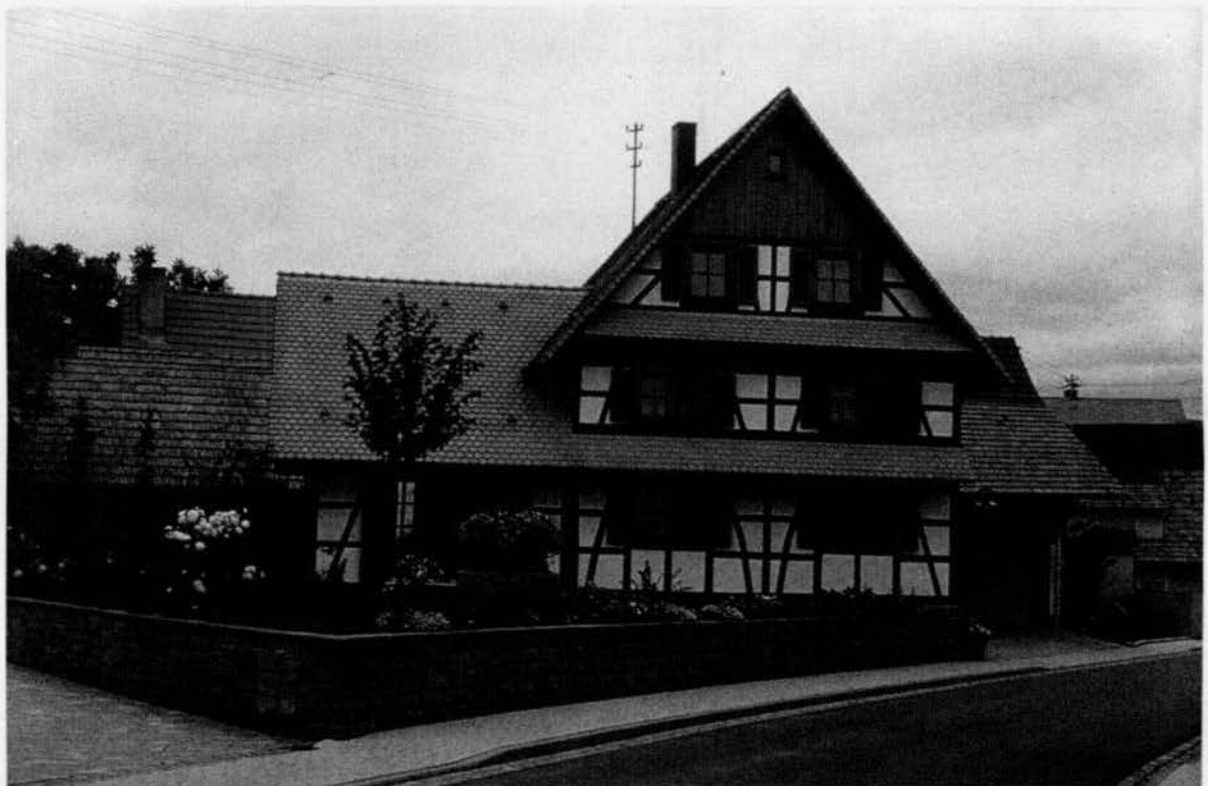
Außenrenovation Fachwerkhaus, Renchen-Ulm
