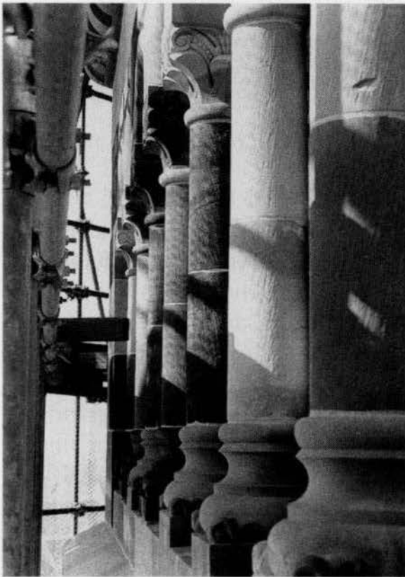
Vollständig erneuerte Säulchen und Bögen der oberen neuromanischen Zwerggalerie, 1991
