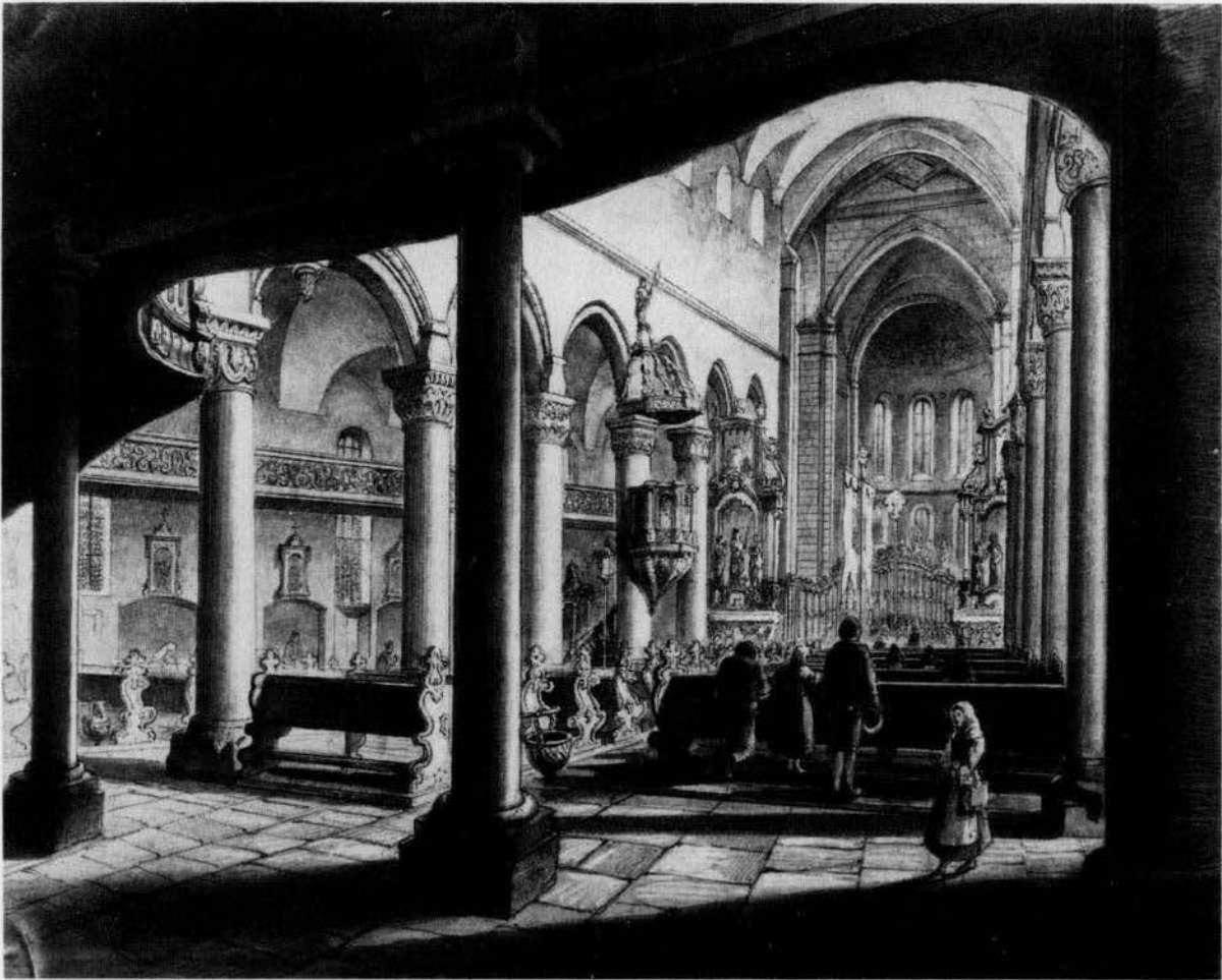
Abb. 5: Innenansicht, Mittelschiff nach Osten, ca. 1892. Lavierte Bleistiftzeichnung vom G.M. Eckert (LDA, Graphiksammlung, Neg.Nr. 10626). Die Ostpartie im ersten Restaurierungsabschnitt bereits umgestaltet, das Langhaus noch mit barocker Ausgestaltung (Stuckgewölbe, Seitenschiffemporen, Nischen in den Seitenschiffwänden, Kanzel, Altäre usw.).
