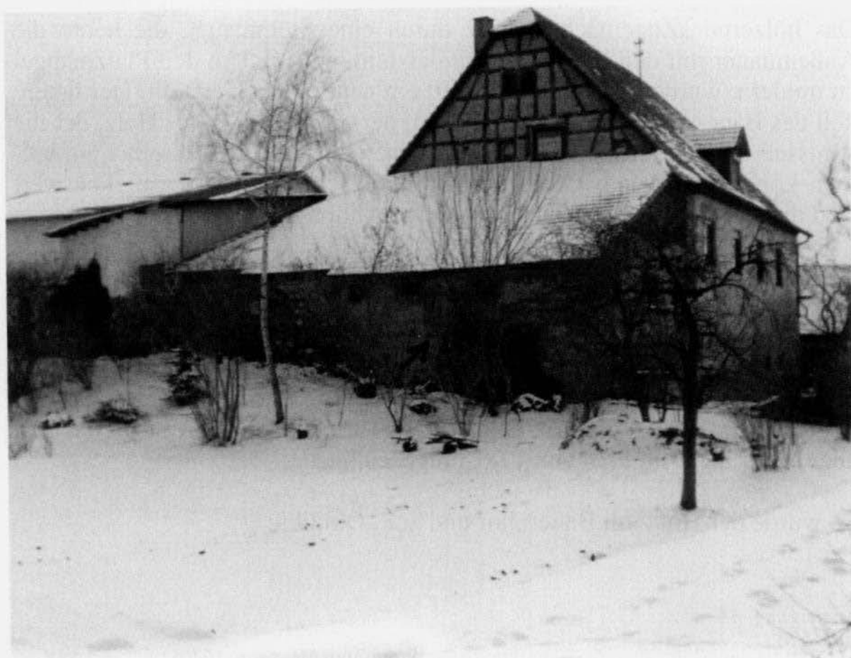
Abb. 12: Heutiger Zustand des Hauses. Wappen Nr. 1 (Pfeil) Erkennbar der Trockengraben (Verbindungsmauer zur Stadtmauer entfernt) (links Schutthügel vom Wehrturm)
