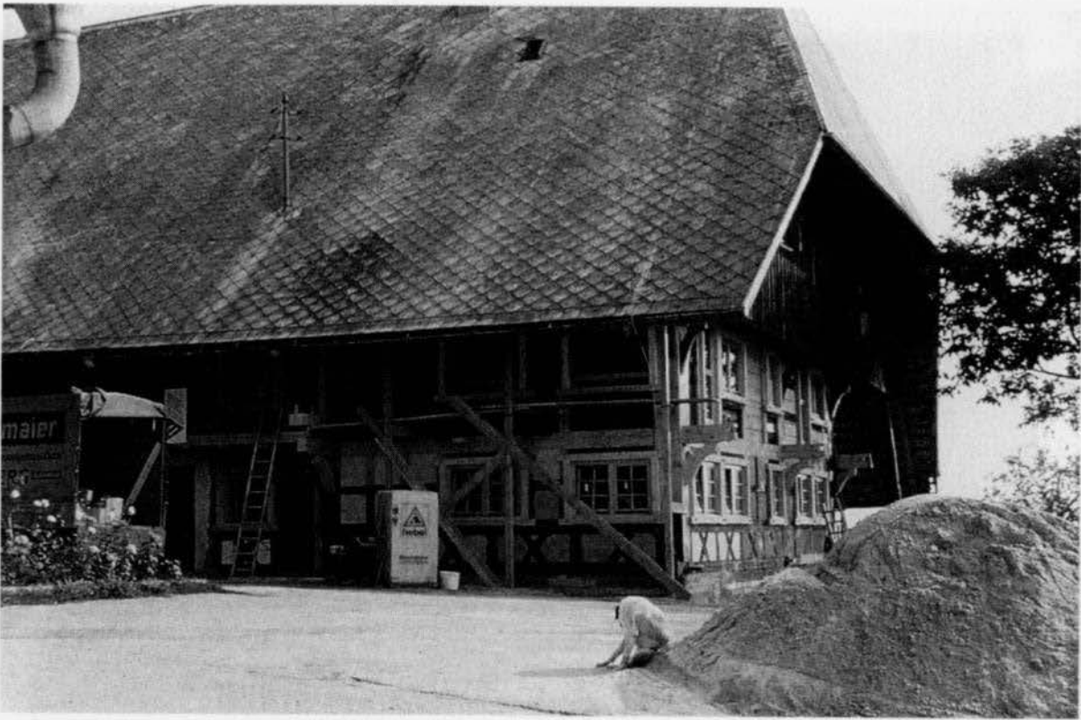
Gesamt-Renovierung – Kräherhof –, Hornberg-Reichenbach
