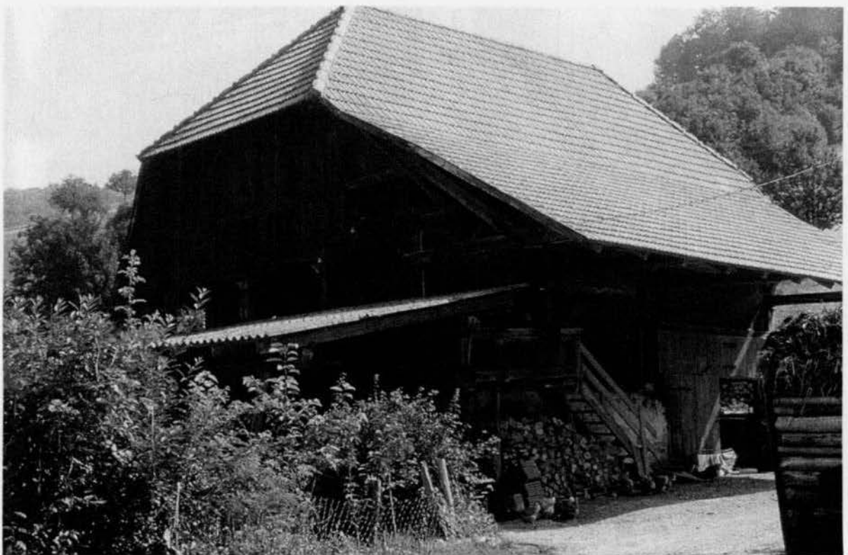
Instandsetzung Speichergebäude – Rufenhof –, Welschensteinach
