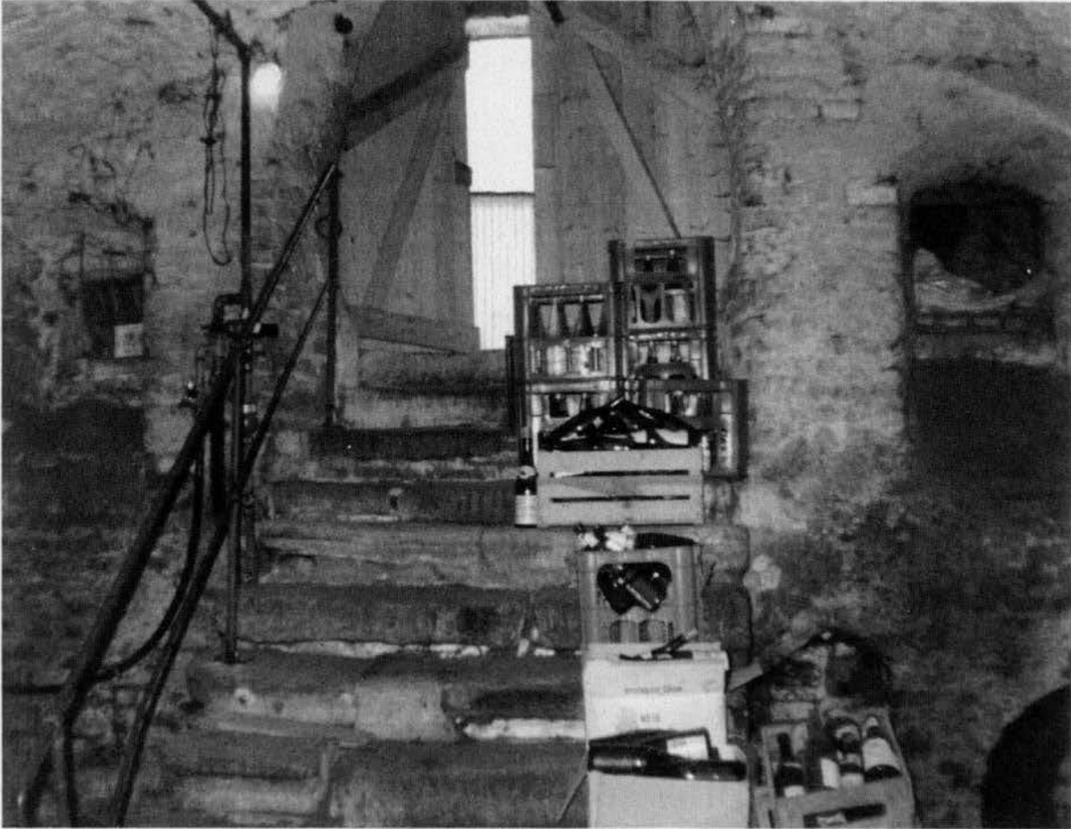
Abb. 4: Treppe aus Sandsteinen
