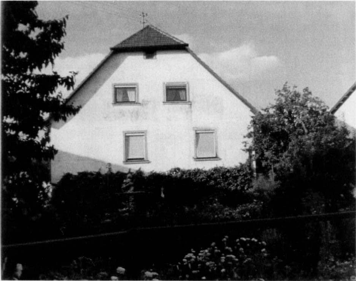
Abb. 7: Heutiger Zustand des Hauses Dorsner/Reinfried ehem. Pallas (Süden)
