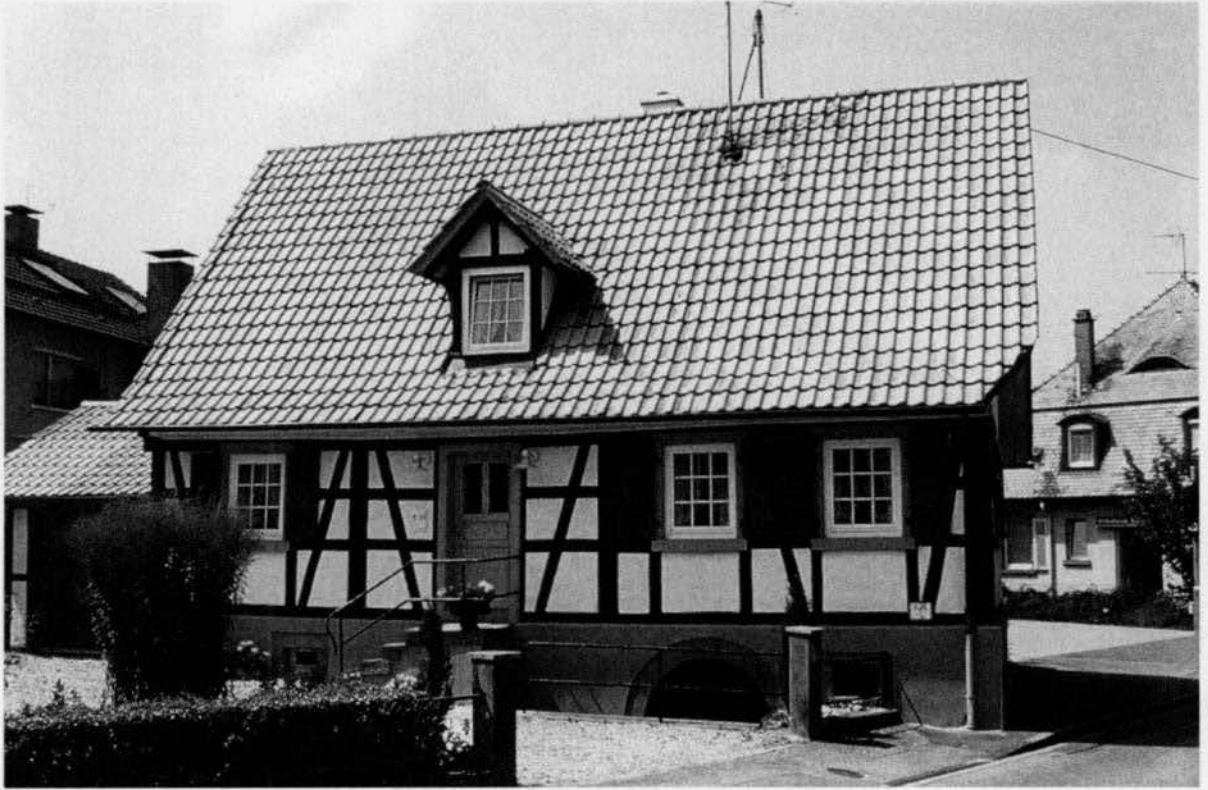
Renovierung Fachwerkhaus, Heiligenzell
