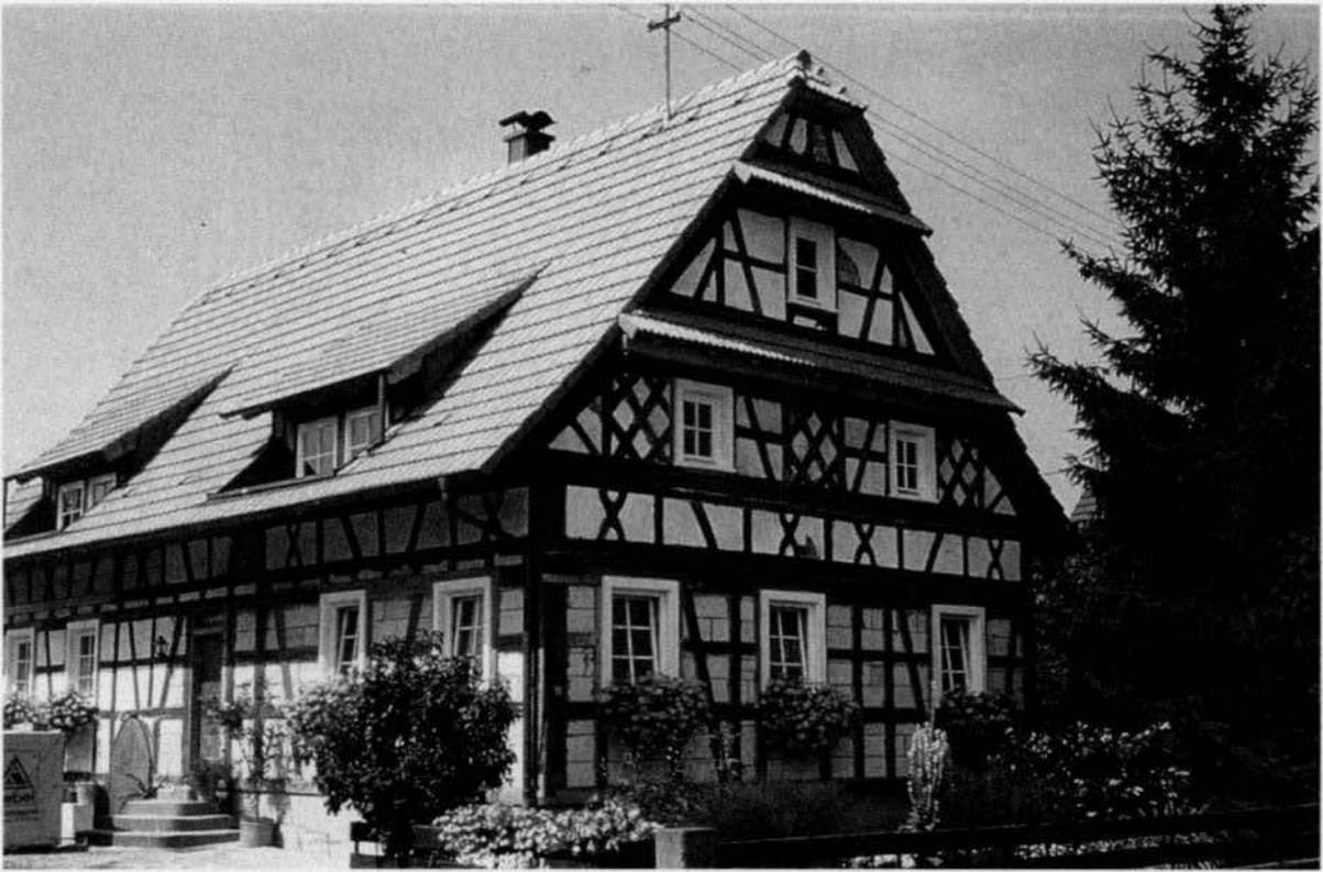
Renovierung Fachwerkhaus, Schutterwald-Höfen
