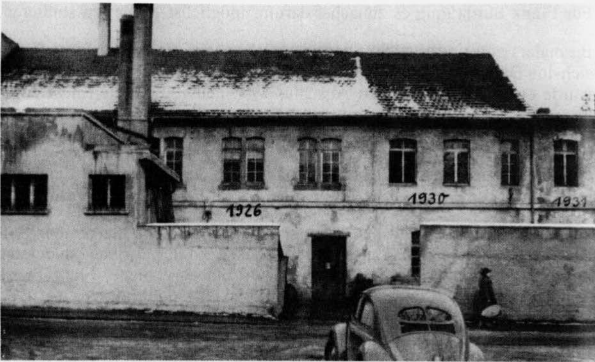
Die erste Druckerei im Hinterhaus der Metzgerei Burg mit Erweiterungen
