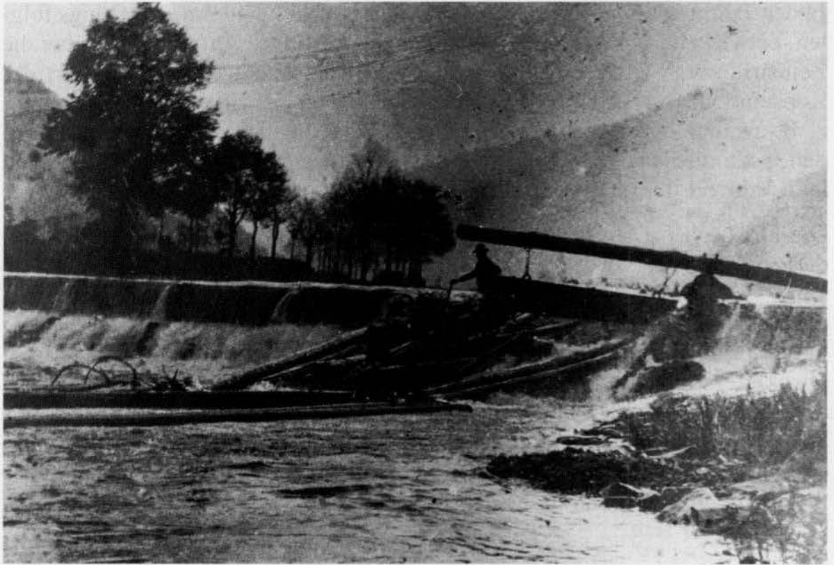
Landfloß auf der Fahrt über den Spitzteich in Wolfach. Die Floßfalle (der Gamper) ist geöffnet.
