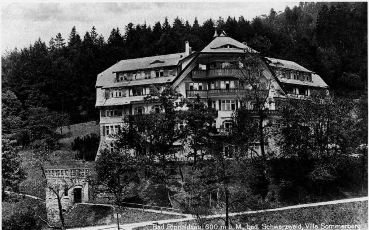
Villa Sommerberg, 1908 erbaut
