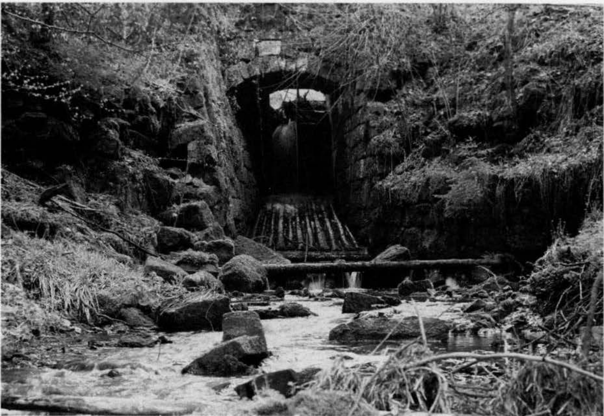
Wasserdurchlaß des Floßweihers im Heubach, unmittelbar oberhalb des Rüstplatzes (Einbindestätte gelegen).
