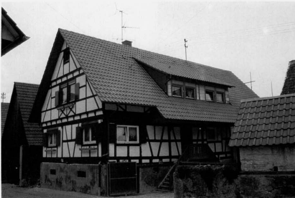
Fachwerkhaus in Lahr-Sulz Aufnahme: Archiv Ortenaukreis
