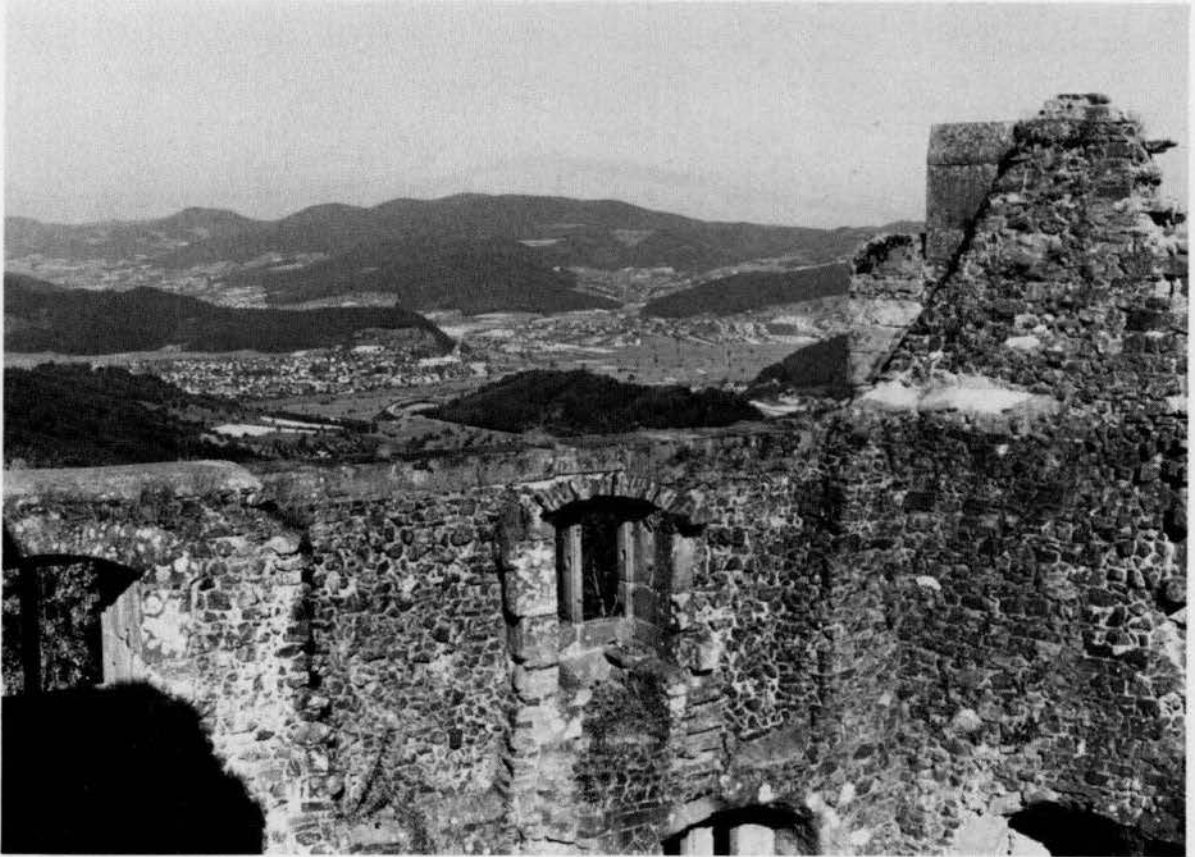
Die Hohengeroldseck: Blick über den Palas nach Osten.
