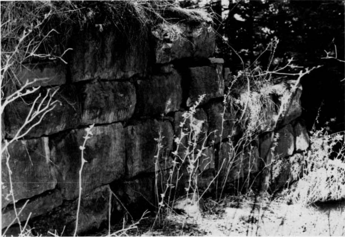
Die östliche Außenmauer der Willenburg, aufgesetzt aus großen Quadern mit rohen Buckeln ohne Randschlag.
