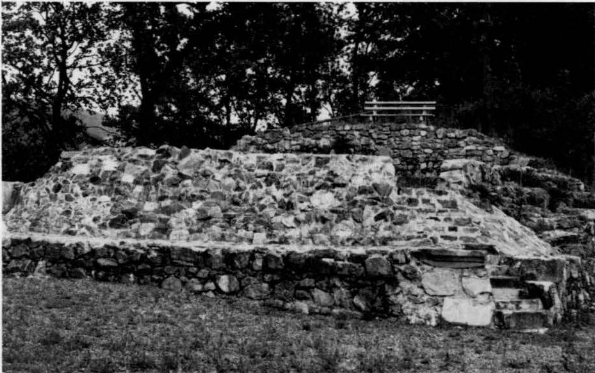
Die Grundmauern des Gutach-Turmes.
