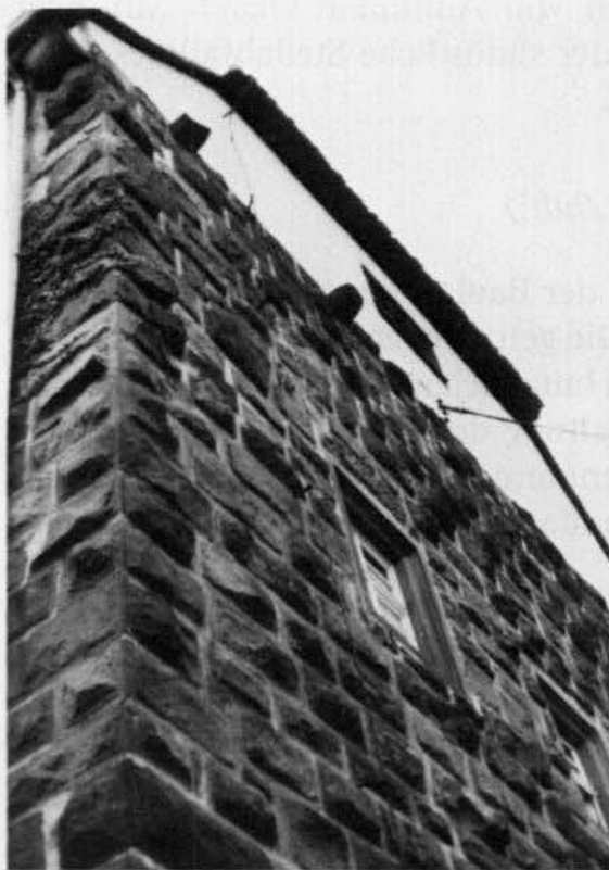
Schloß Mahlberg: Staufische Wehr- mauer mit Buckelquadern.
