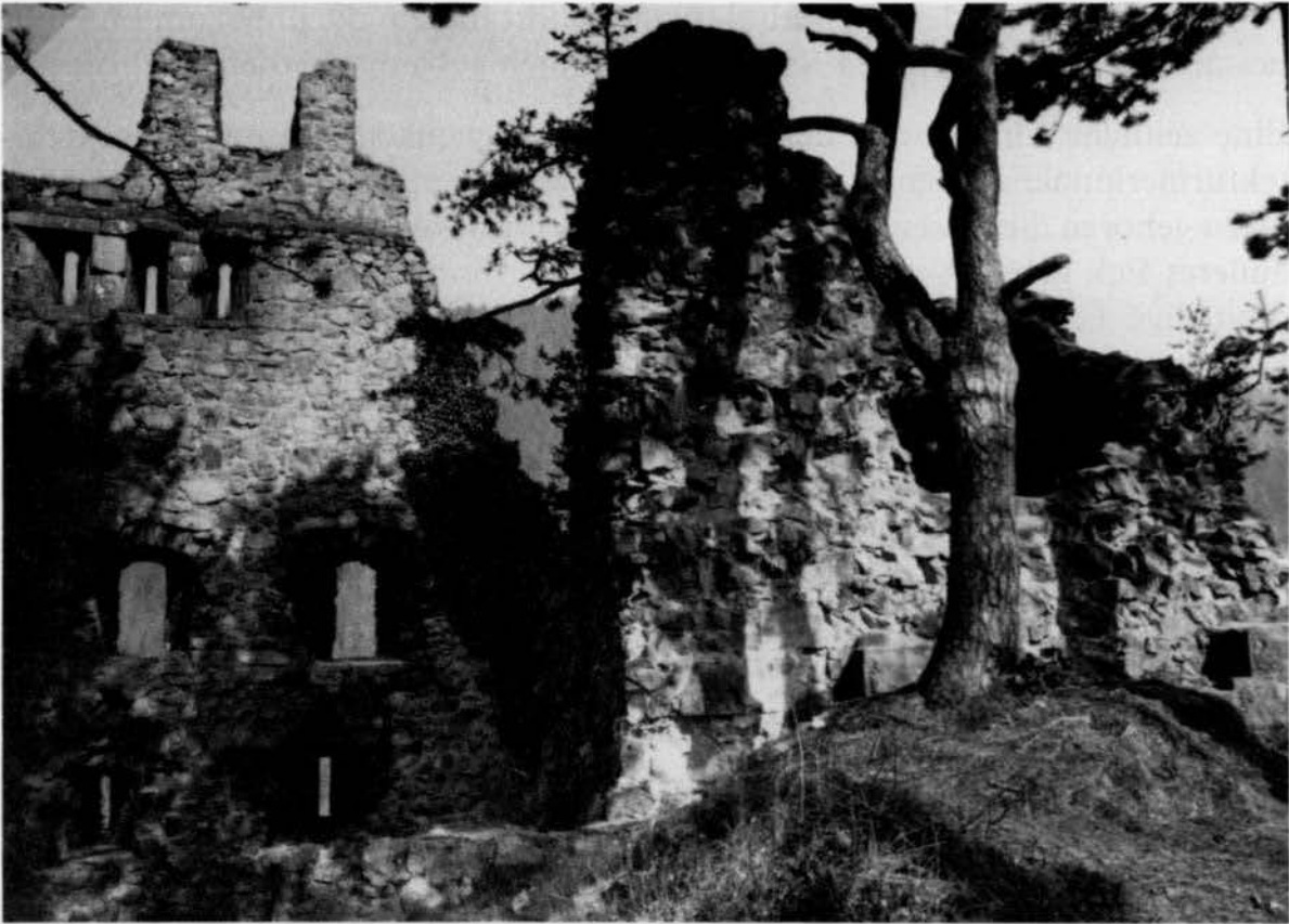
Die Schenkenburg: Innenwand des Palas und Mauerkerne des Bergfrieds mit den Resten seiner Buckelquaderummantelung von Süden.
