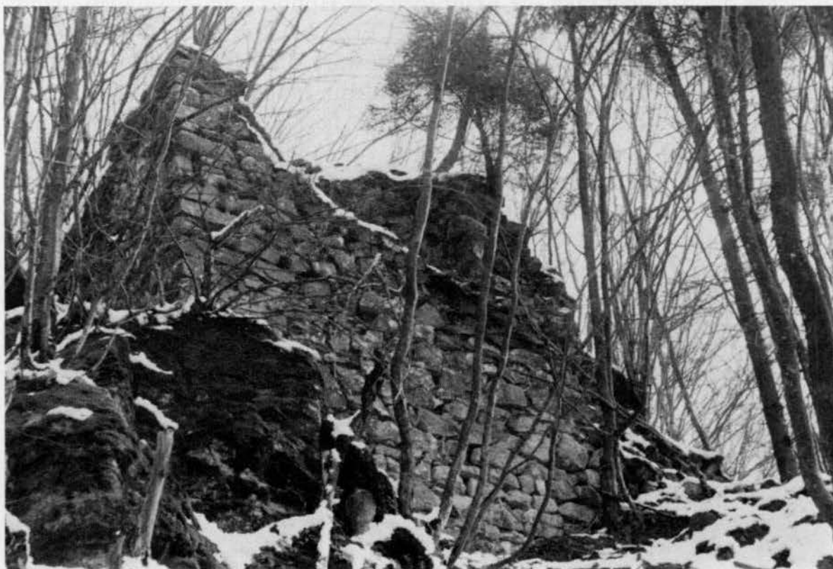
Die Burg Walkenstein: Ansicht von Nord-West.
