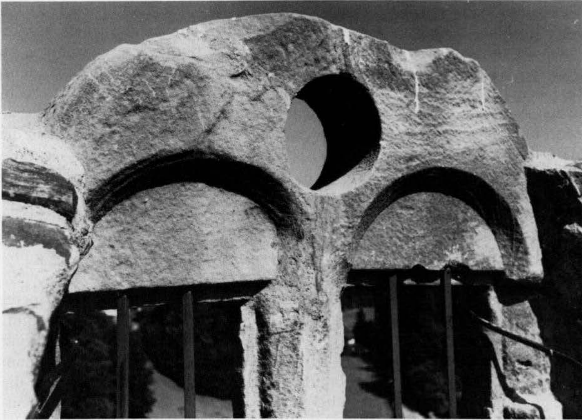
Schloß Diersburg: Gekuppeltes Rundbogenfenster des Palas.
