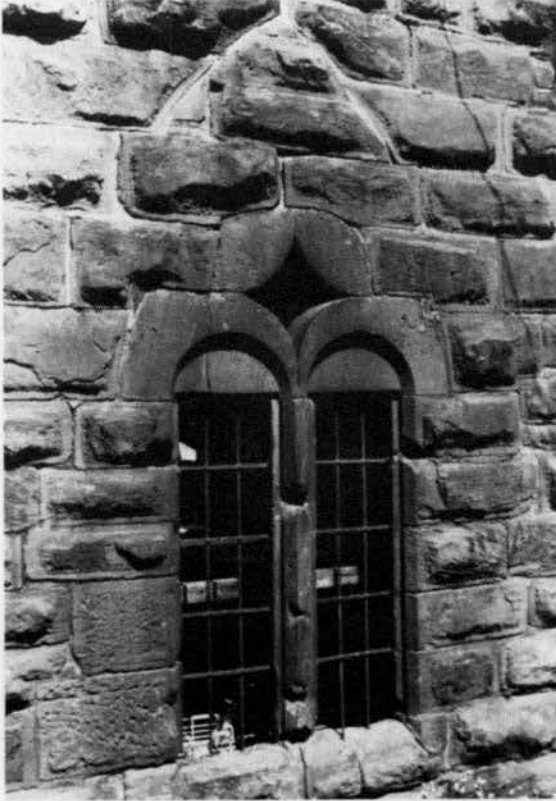
Tiefburg Lahr: Gekuppeltes Rundbogenfenster des Palasuntergeschosses. Aufn.: J. Mühlhan
