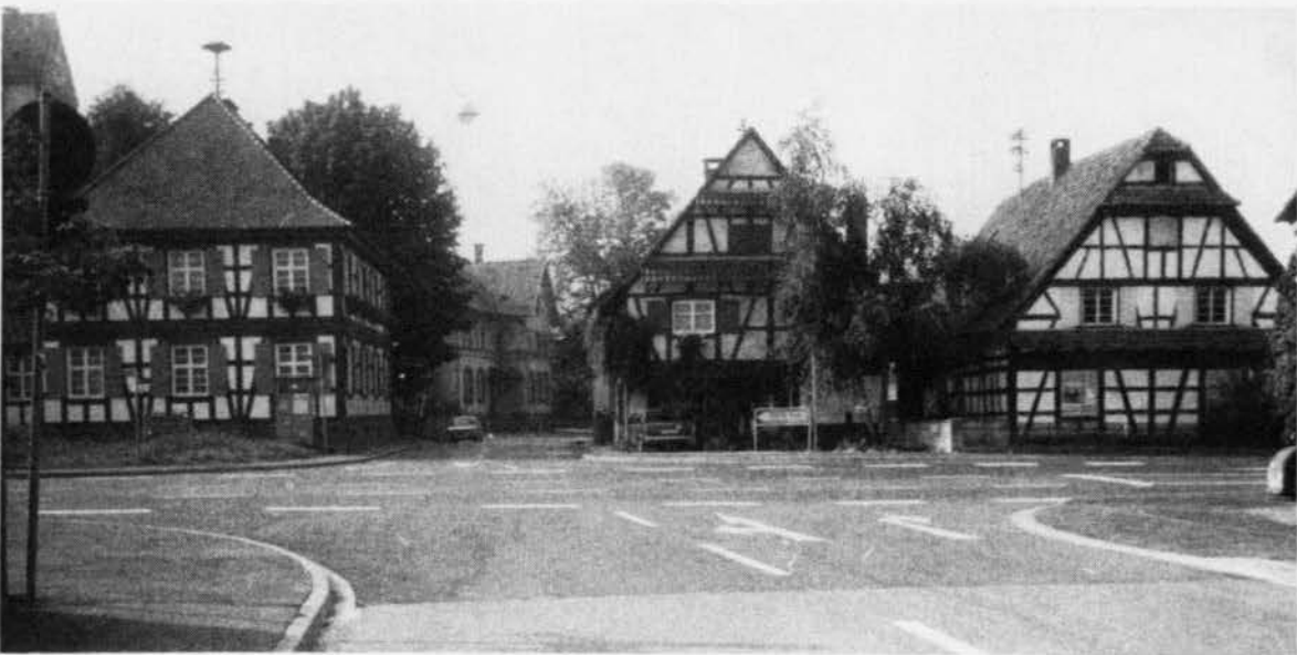
Fachwerkhäuser im Ortskern von Bodersweier
