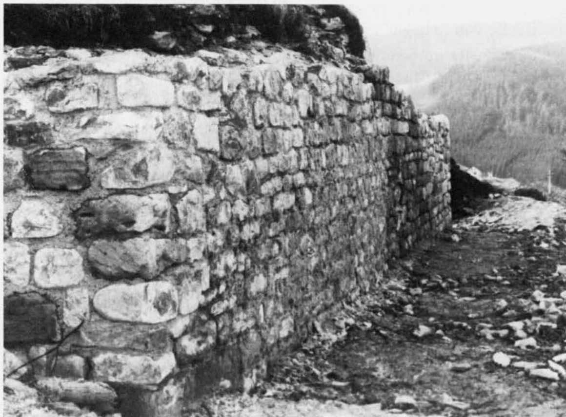
Freigelegtes Stück des Bergfrieds, Nordseite. 11. Jahrhundert. Nach umfangreichen freiwilligen Arbeitseinsätzen wurden die Umfassungsmauern des „Schlößle“ freigelegt und ausgebessert.
