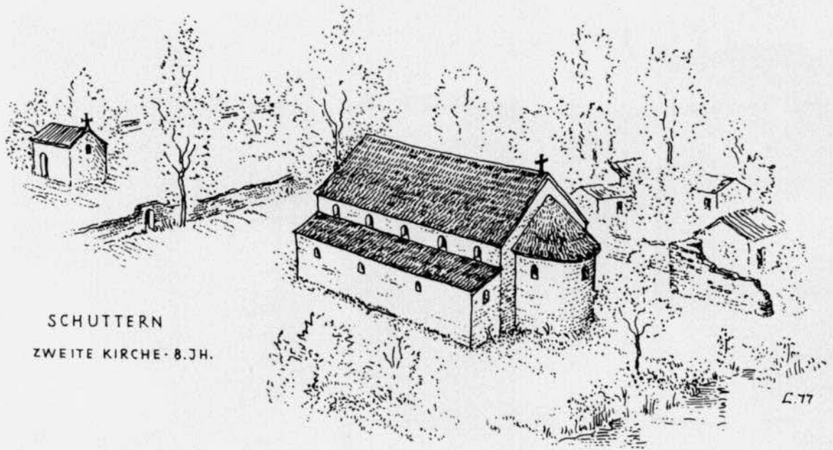
Abb. 5 Rekonstruktion der zweiten Kirche von Südost
