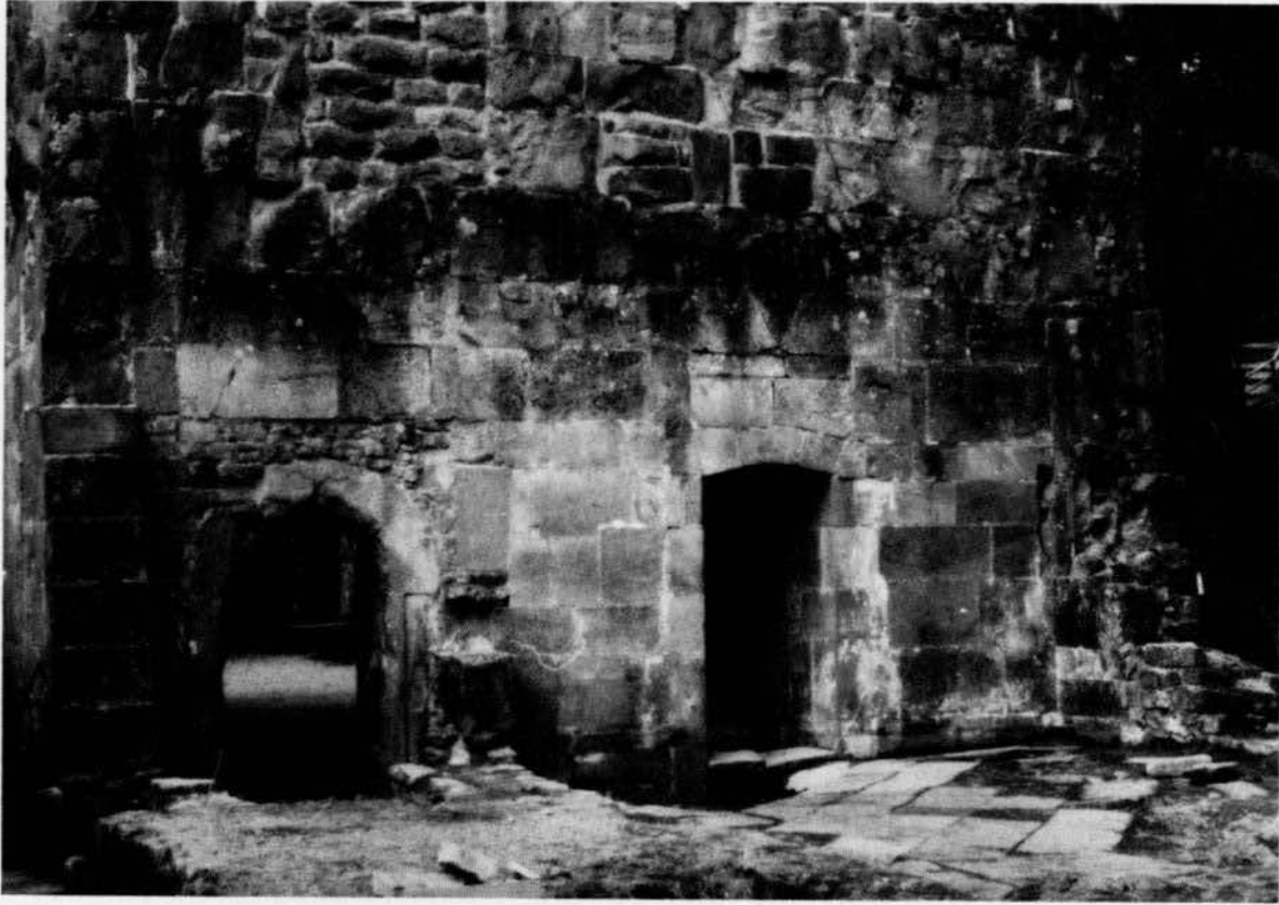
Kloster Allerheiligen, Grabungen 1976/77. Südwand des Querschiffes mit dem Sakristeieingang rechts und dem Durchgang zur Dormitoriumstreppe links (von Süden).
