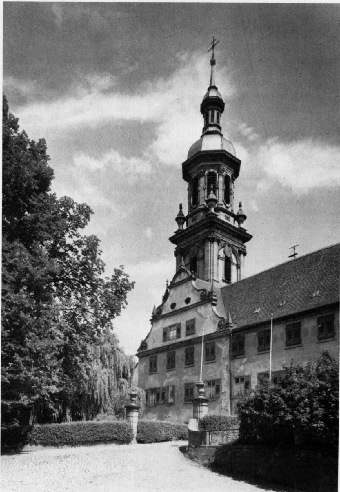
Der barocke Turm der Klosterkirche (1711-1716) und die Konventsgebäude, Teilansicht
