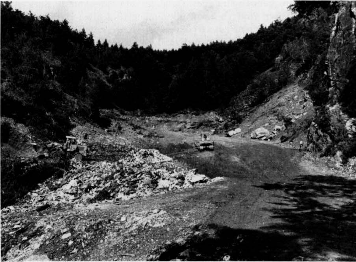
Verdichtungsgerät (Compactor) und Schaufellader sind den ganzen Tag über auf der geordneten Mülldeponie „Vulkan“ in Tätigkeit
