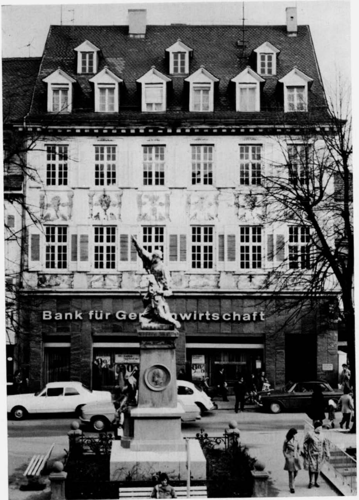
Haus Battiany, Hauptstraße 69
