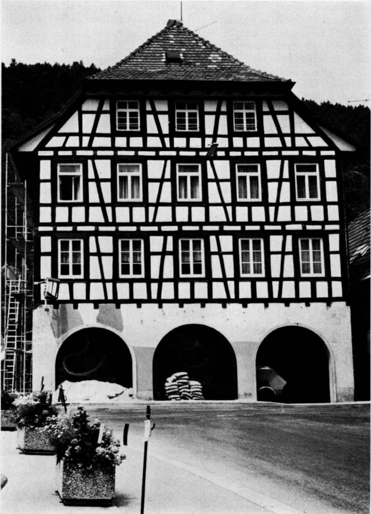
Unter dem jüngst entfernten Verputz des Geschäftshauses J. A. Bühler an der Stadtbrücke erscheint eine einheitliche und regelmäßige Fachwerkkonstruktion, die mehr der Zweckmäßigkeit, als dem Schmuckbedürfnis folgt. Das Haus wurde zwischen 1770 und 1800 erbaut.
