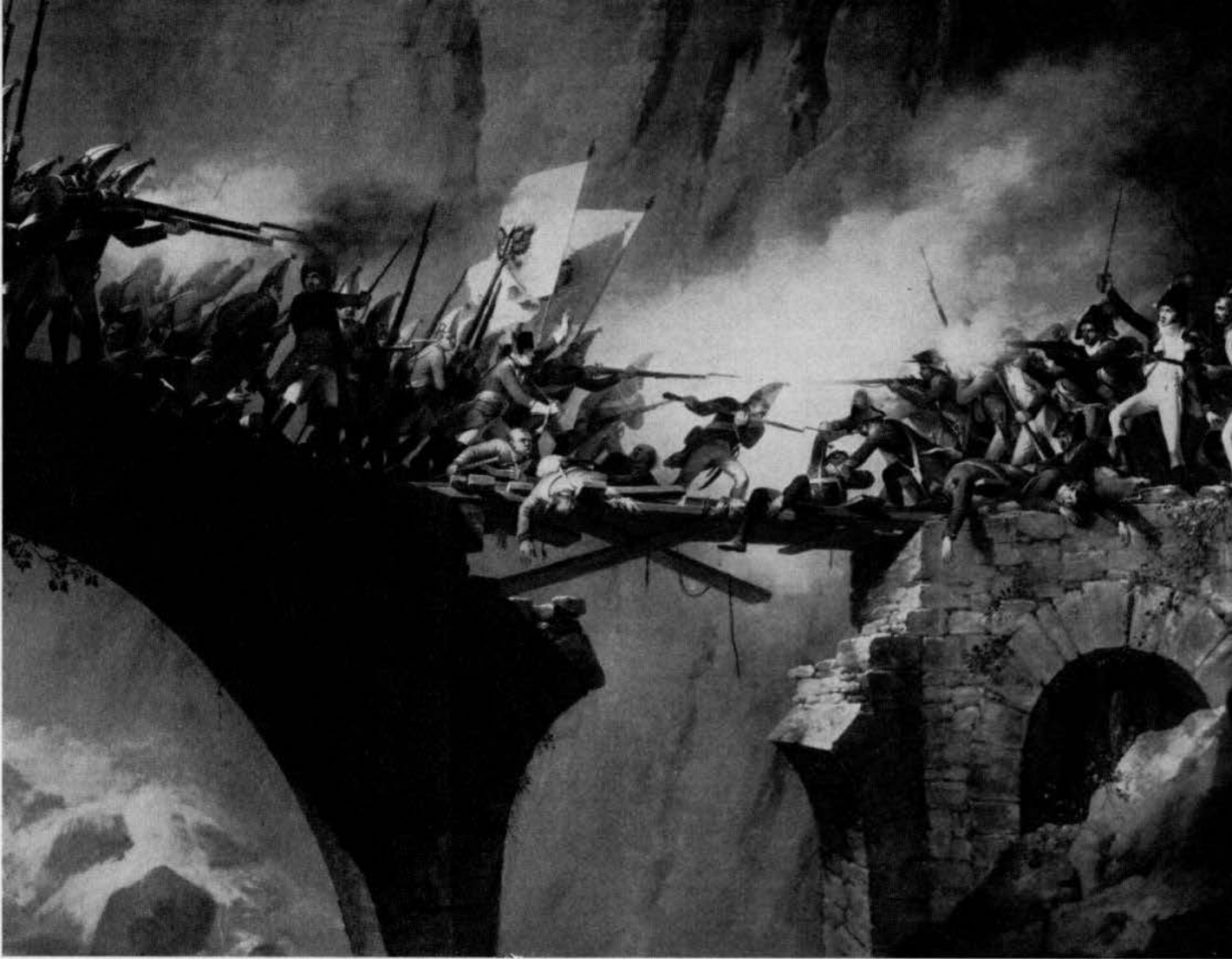
Johann Baptist von Seele Der Übergang über die Teufelsbrücke Staatsgalerie Stuttgart
