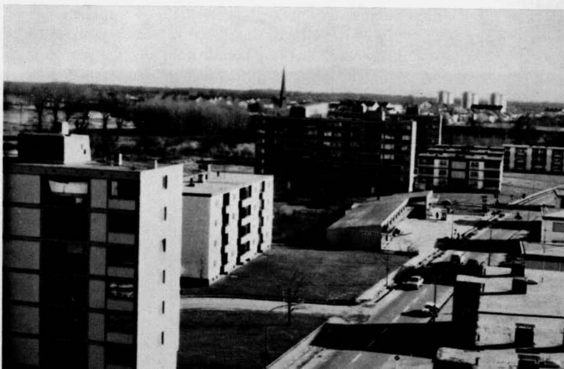
Teil der Neubauten beim Richard-Wagner- Ring in Rastatt.
