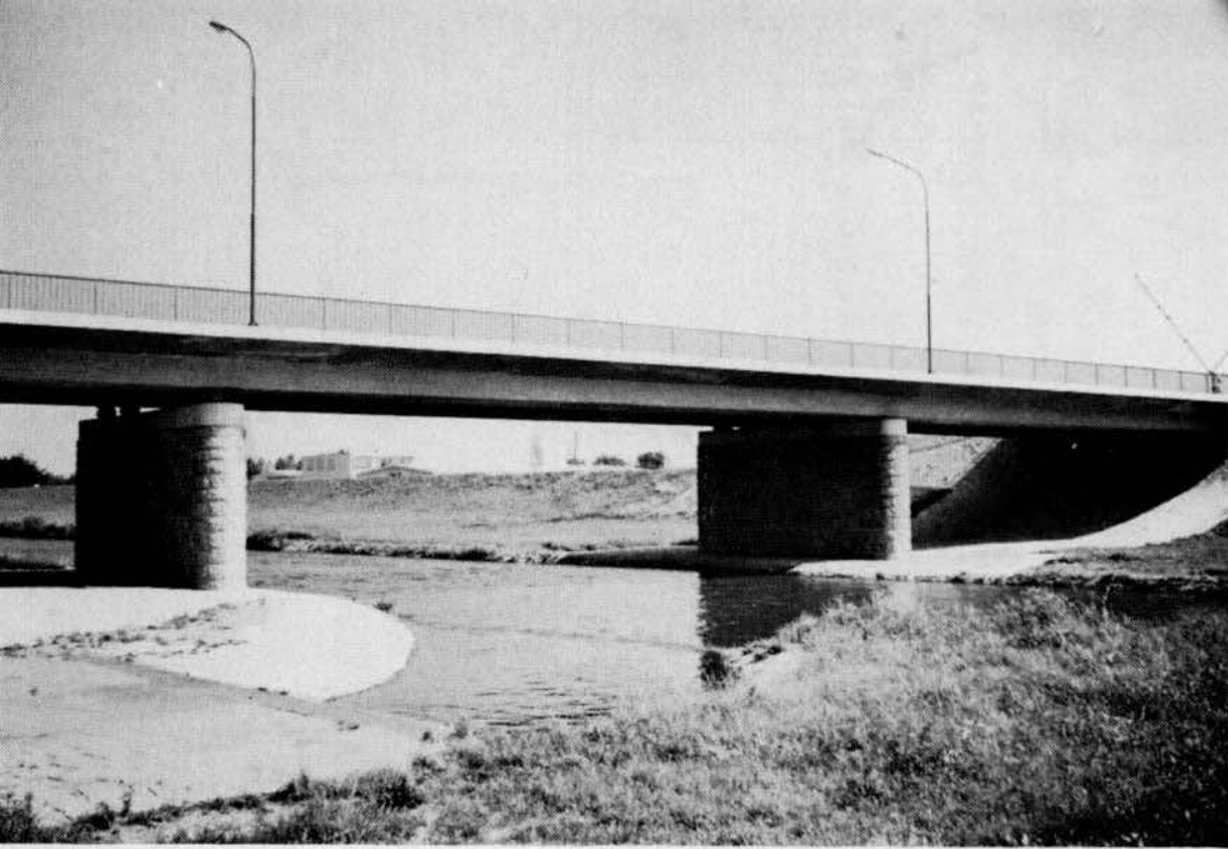
1968 wurde ein neuer Kinzigübergang geschaffen zur Entlastung des älteren Übergangs: die Otto-Hahn-Brücke.
