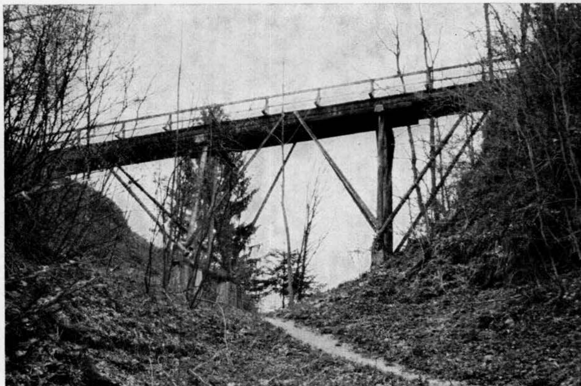
Der Halsgraben der Burg Schiltach. Länge der Holzbrücke 23,00m, Grabentiefe vom Brückenboden aus 8,80 m.
