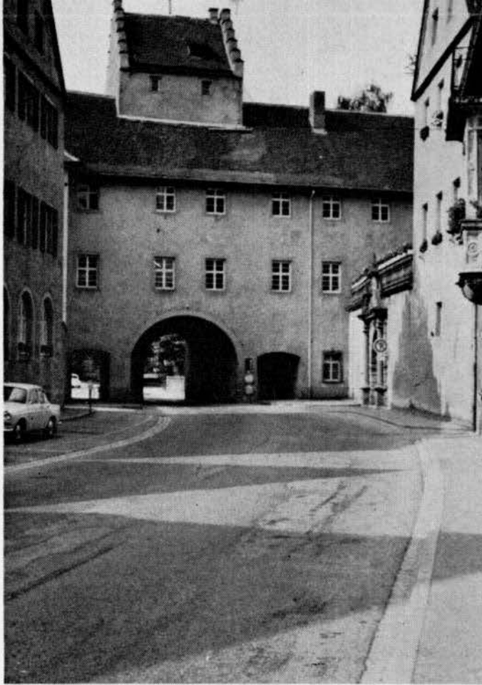
Das Stadttor mit den neuen Fußgängertoren, von der Stadtseite aus. Rechts der Erker des ehemaligen Amtshauses.
