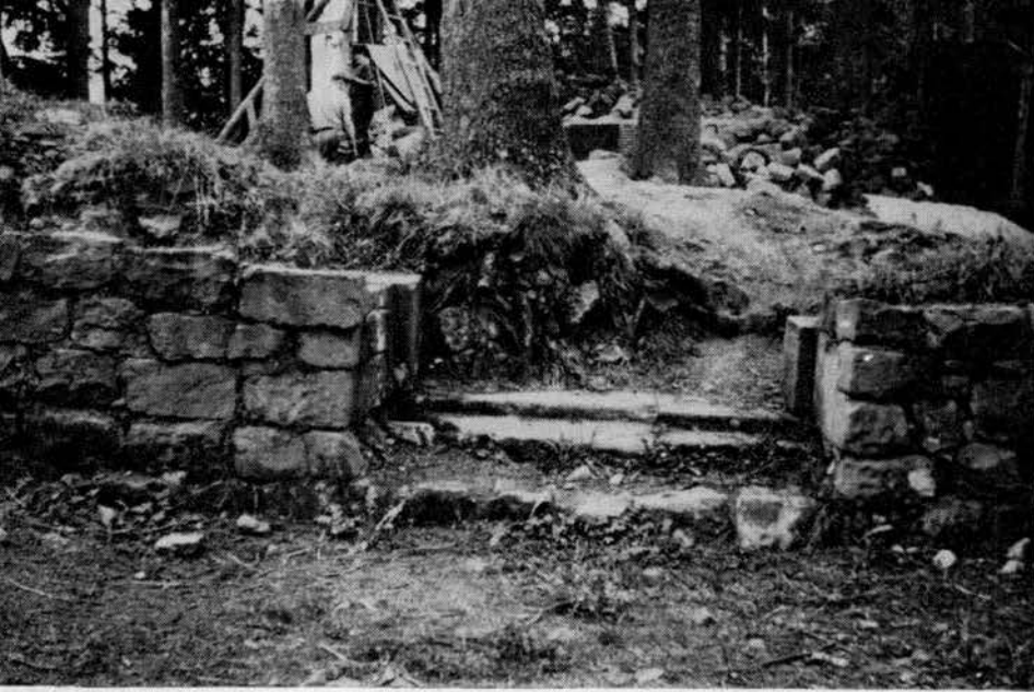
Willenburg, der „Große Eingang“ mit Schwelle und Anschlagsteinen.
