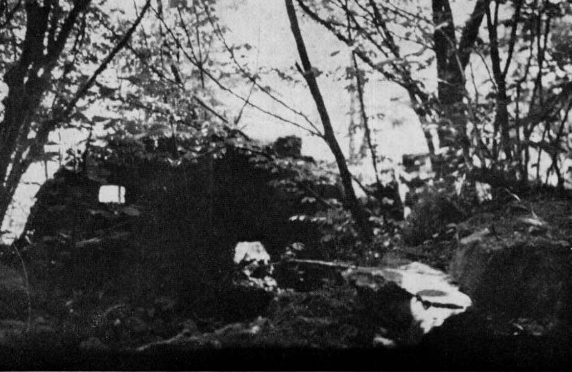
Ruine Walkenstein. Das Innere des Wohnturmes mit der Westmauer. Aufn.: H. Fautz
