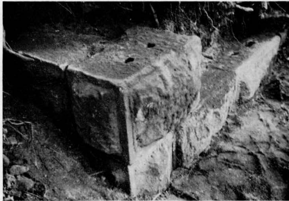
Nordecke der ehemaligen Klingenburg. An den Quadern sind z. T. die Zangenlöcher zu sehen, gebuckelt mit Randschlag.
