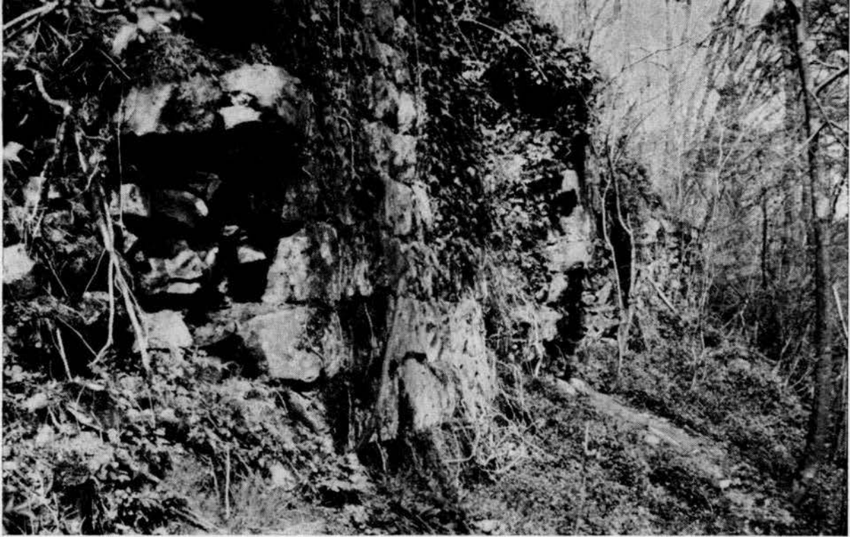
Burgruine Schiltach. Das einzige erhaltene Mauerstück in der südlichen Burgmauer. Verblendung mit Buntsandsteinquadern (Größe bis 70 x 40 x 25 cm) im Läuferverband in Kalkmörtel gesetzt; noch 10 bis 12 Schichten vorhanden; Mauerhöhe bis 3,20 m, Mauerstärke 2,00 bis 2,50 m. Aufn.: H. Fautz
