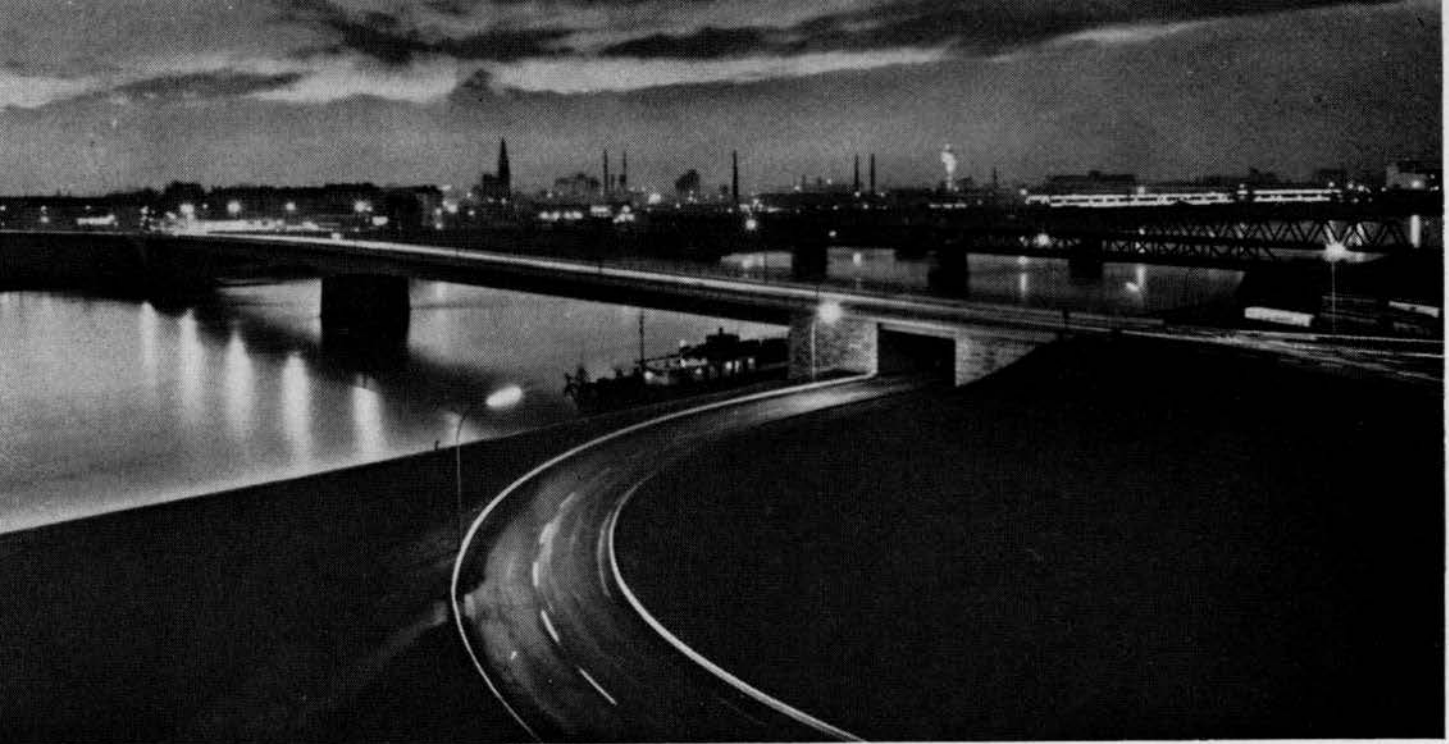
Die Stahlbeton-Rheinbrücke unserer Zeit mit nur einem Pfeiler im Strombett und einer Höhe, daß die Rheinschiffe bequem darunter durchfahren können.
