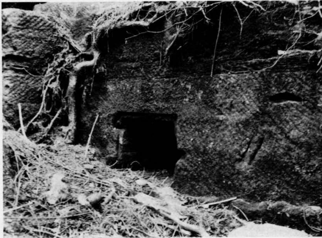
Noch vorhandene Mauerreste der Heidburg mit einem Fenster oder einer Nische.
