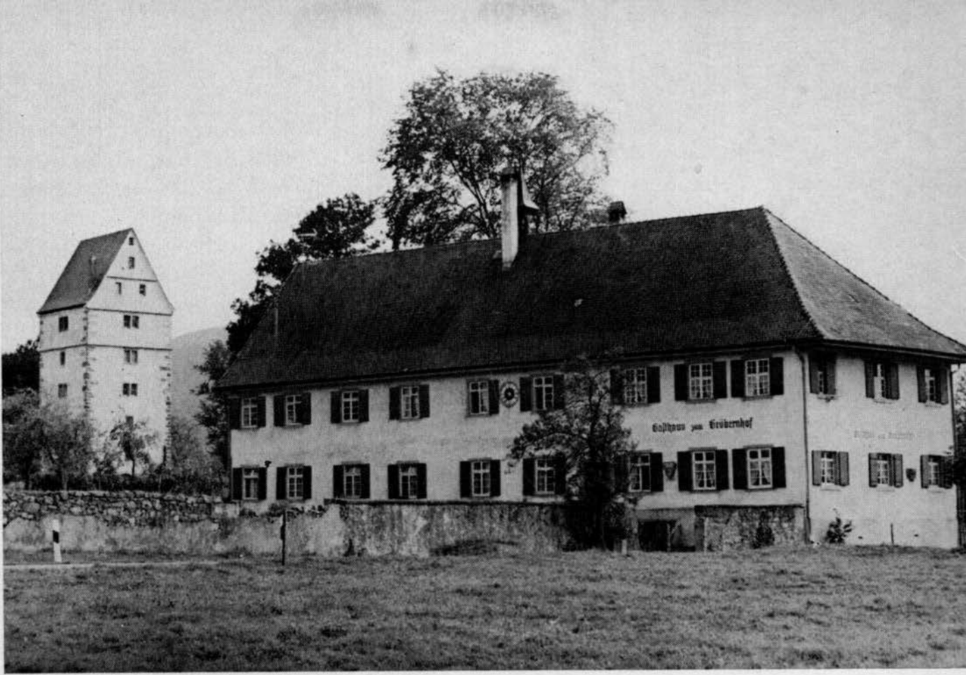
Heutiges Aussehen der Wohnburg Gröbern. Das Innere wurde vor einigen Jahren zu moderner Wohnlichkeit hergerichtet. Heute bewohnt. Zum heutigen Bestand gehört außer dem Gasthaus links davon ein hier nicht sichtbares großes Wirtschaftsgebäude. An der Straßenfront des Gasthauses und über dem Eingang zum Adelsturm das Wappen der Familie von Meyershofen. Aufn.: Foto-Müller, Zell a. H.
