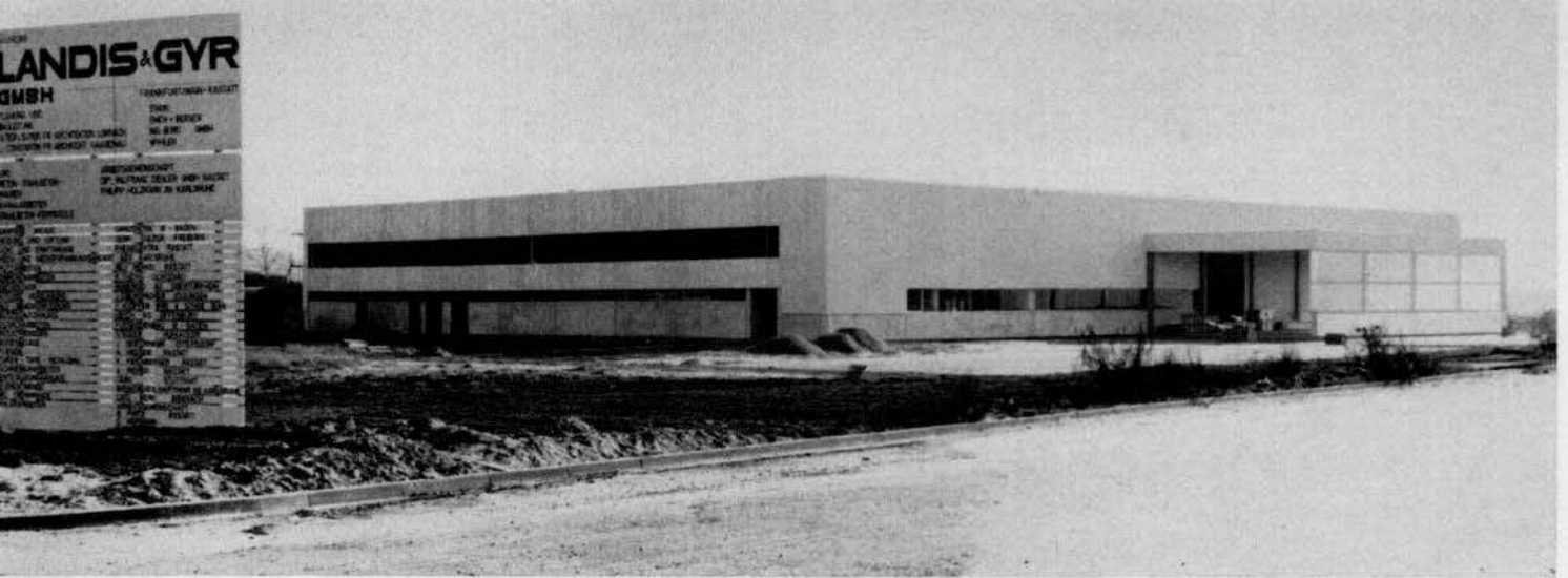
Der große Fabrikneubau der Firma Landis & Gyr im Gewinn Lohfeld.
