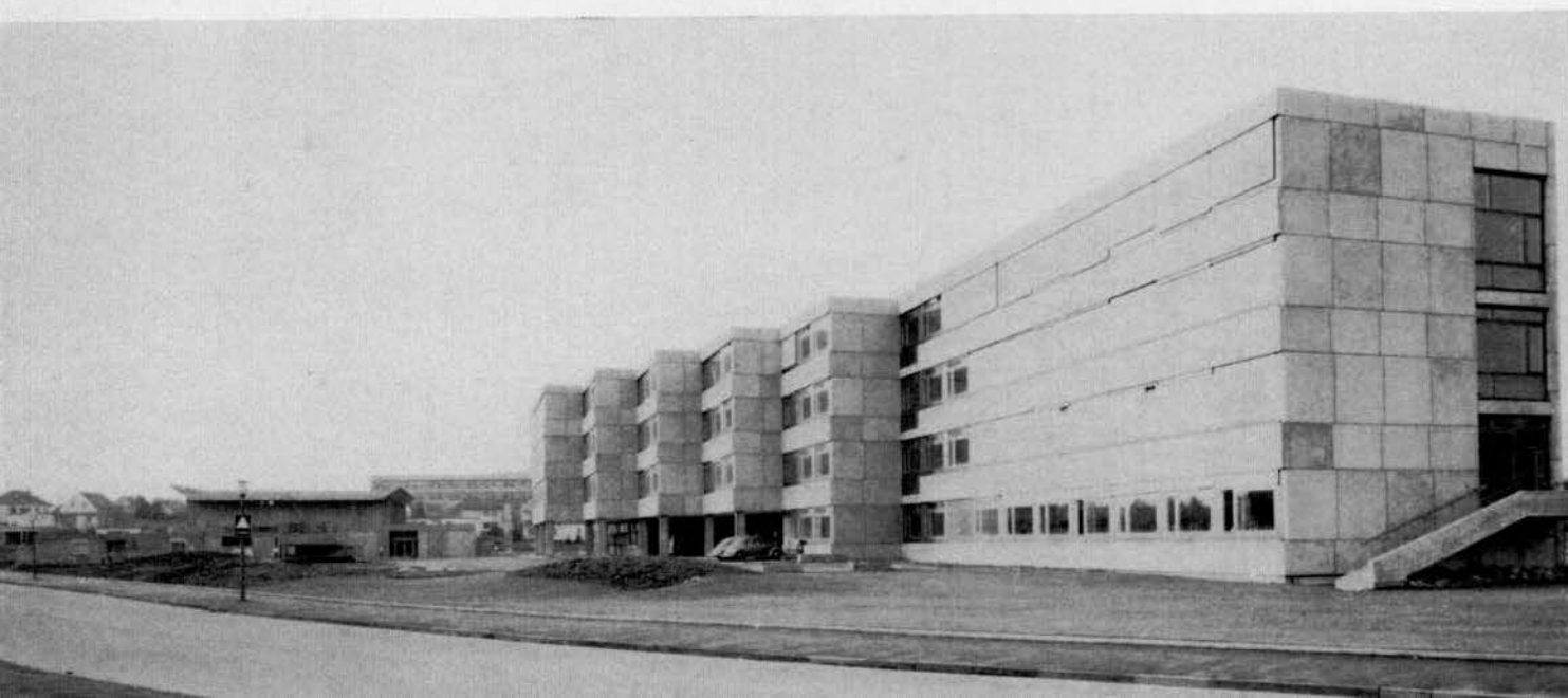
Das Tulla-Gymnasium an der Danziger Straße.
