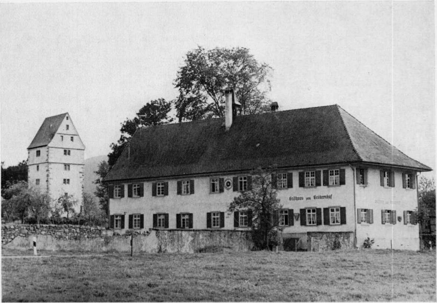
Der heutige Bestand des ehemals adeligen Gutes Gröberhof mit dem bewohnten Turm. Am Gasthaus in der Mitte eine alte Uhr und auf dem Dach das Glockentürmchen.
