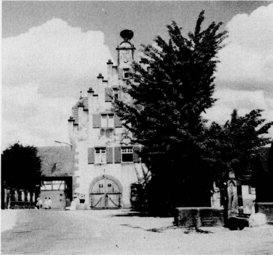
Das althistorische Rathaus mit dem Stockbrunnen davor. Das Rathaus wurde vor zwei Jahren mit Hilfe der Staatlichen Denkmalpflege stilgerecht restauriert.
