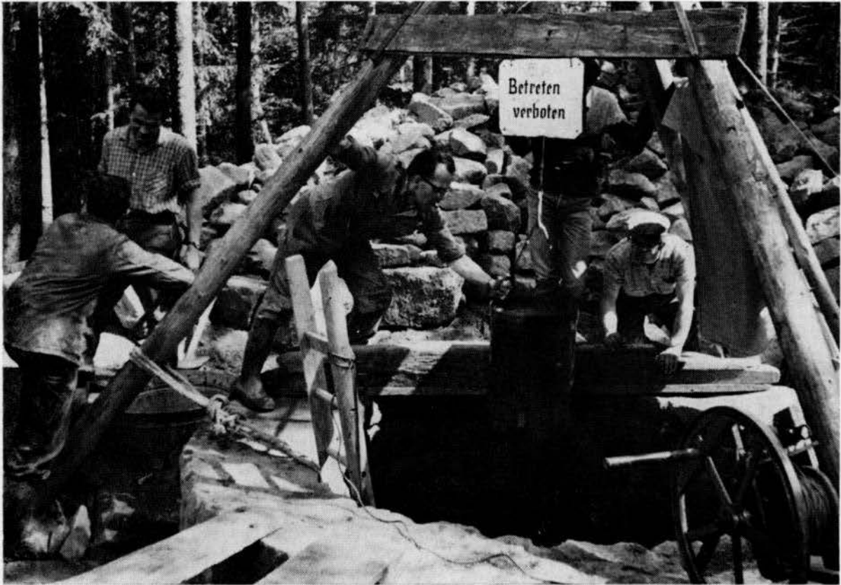
Bild 3 Herbert Pfau mit einigen Helfern beim Abnehmen des aufgezogenen Aushubs.
