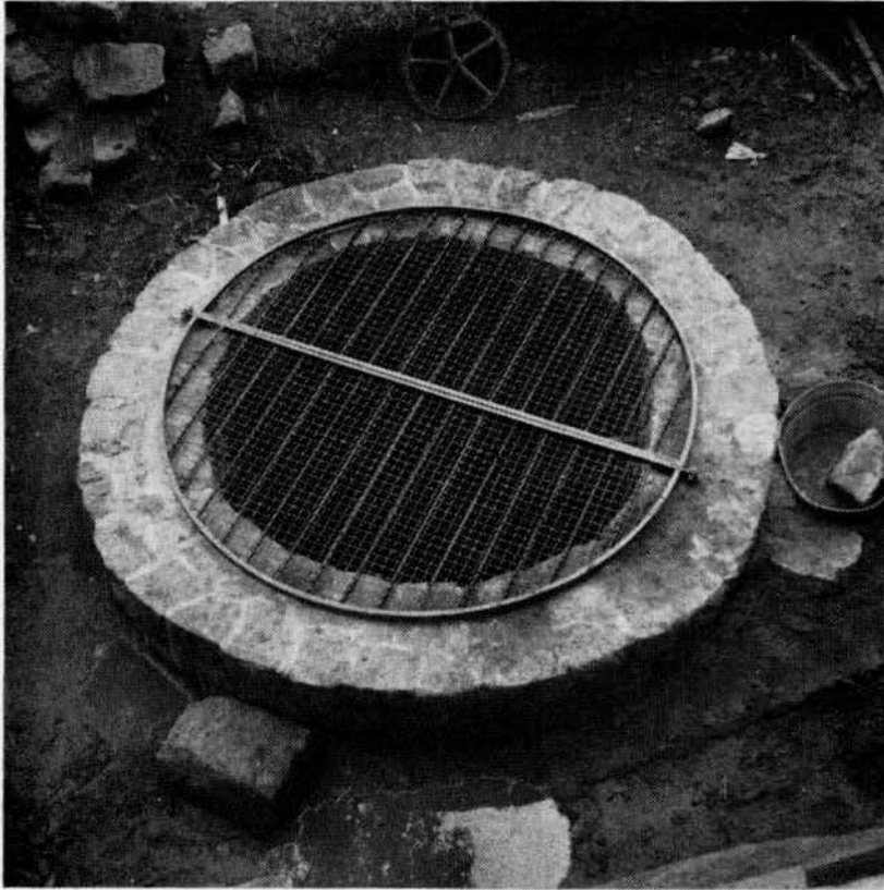
Bild 7 Der Brunnen ist ausgeräumt und denkmalpflegerisch gesichert. Die Brunnenöffnung wurde zur Verwahrung mit einem Gitterdeckel verschlossen.
