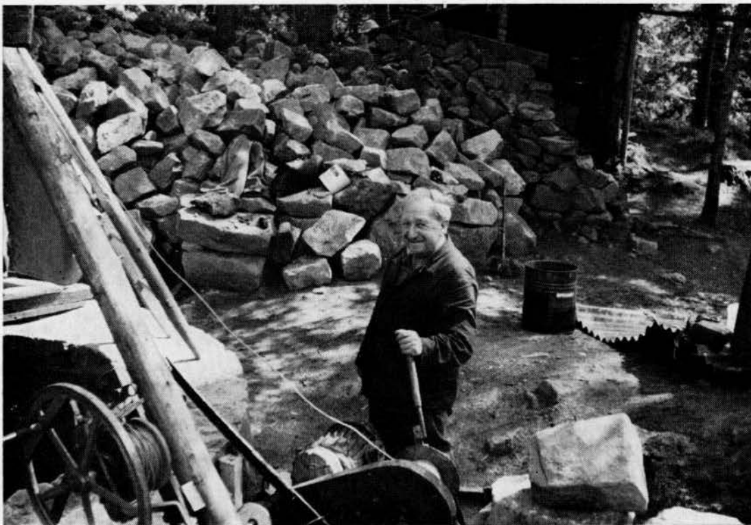
Bild 4 Fritz Laib am Schalthebel des Elektro-Aufzuges. Im Hintergrund die Masse der geborgenen unbehauenen Bau-Steine der Burg.
