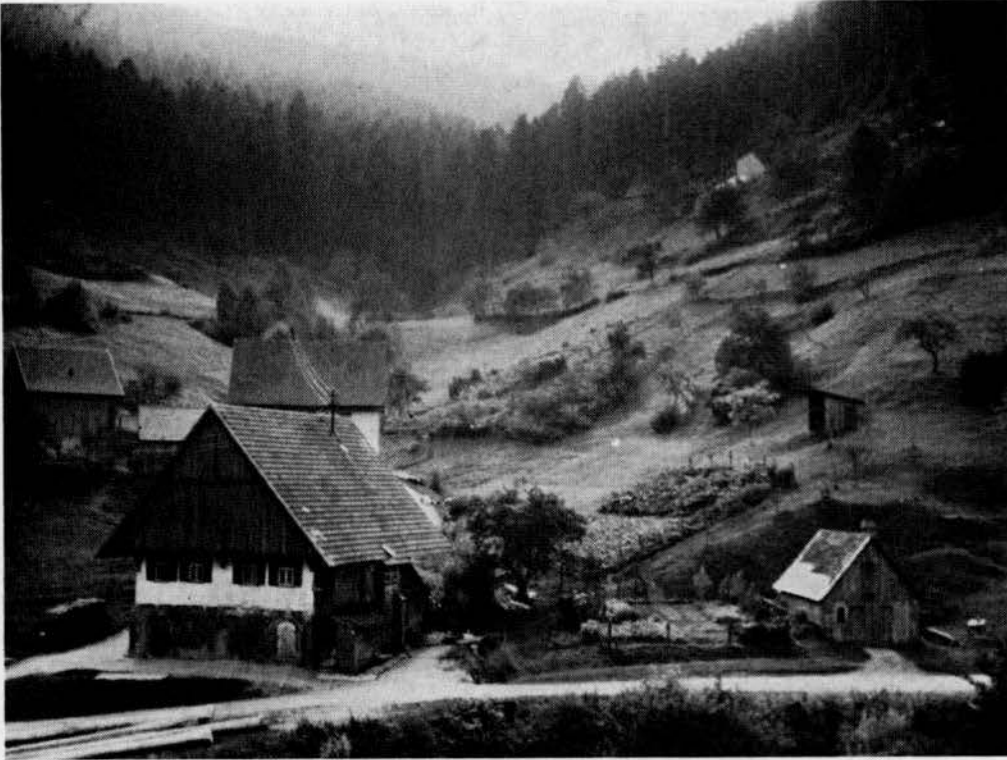
Der Zundelgraben im hinteren Witticher Tal, das Revier der Grube „Güte Gottes“. Im Vordergrund der Witticher Talweg. Hinter dem kleinen Schuppen unten am Weg in der rechten Ecke befindet sich das Mundloch des „Unteren Stollens“, auch „Schmiedestollen“ genannt. Es ist heute durch eine eiserne Türe versperrt. Die ebene Kante über dem hinteren Haus im Mittelgrund ist die Vorderkante der Schutthalde des „Oberen Stollens“, der in den rechten Talhang vorgetrieben ist. Sein Mundloch ist heute nicht mehr sichtbar; es liegt in dem Wiesenhang rechts neben der Schutthalde.
