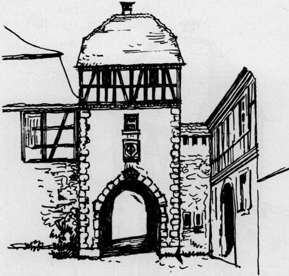
Bühler Tor, Fachwerkaufstockung nach 1766 unter Wiederverwendung des alten, barocken Krüppelwalmdachstuhles. Im Fachwerkgeschoß 2 Gefängniszellen. Das Tor wurde 1810 abgetragen.
