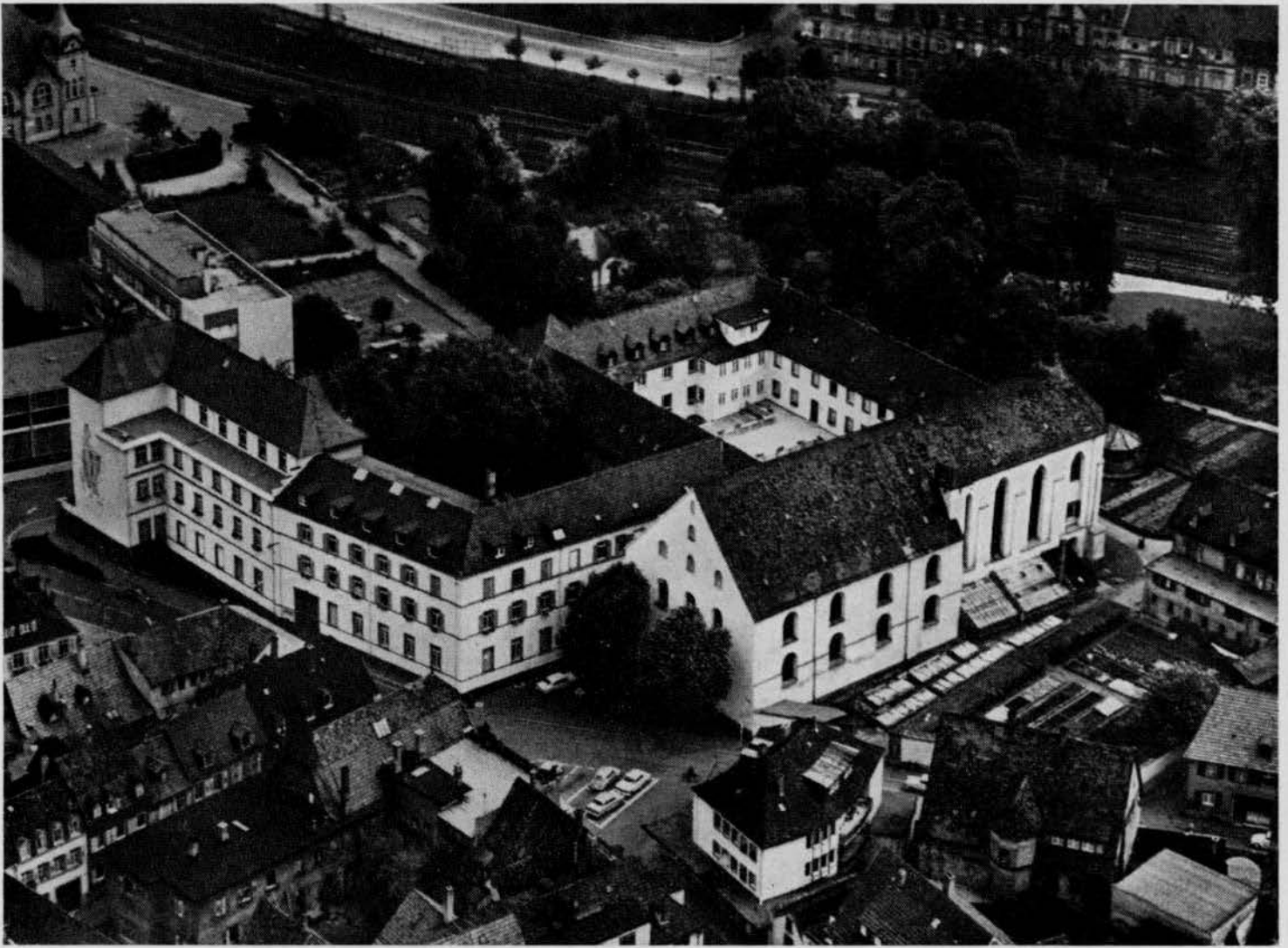
Luftbild der gesamten Baugruppe des Klosters Unserer Lieben Frau samt Mädchengymnasium und Internat in Offenburg.
