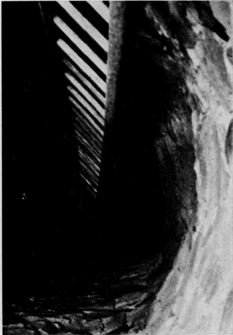
Das Innere der Zisterne mit der an die Arbeitsstelle führenden Leiter zeigt die Tiefe des Schachtes.
