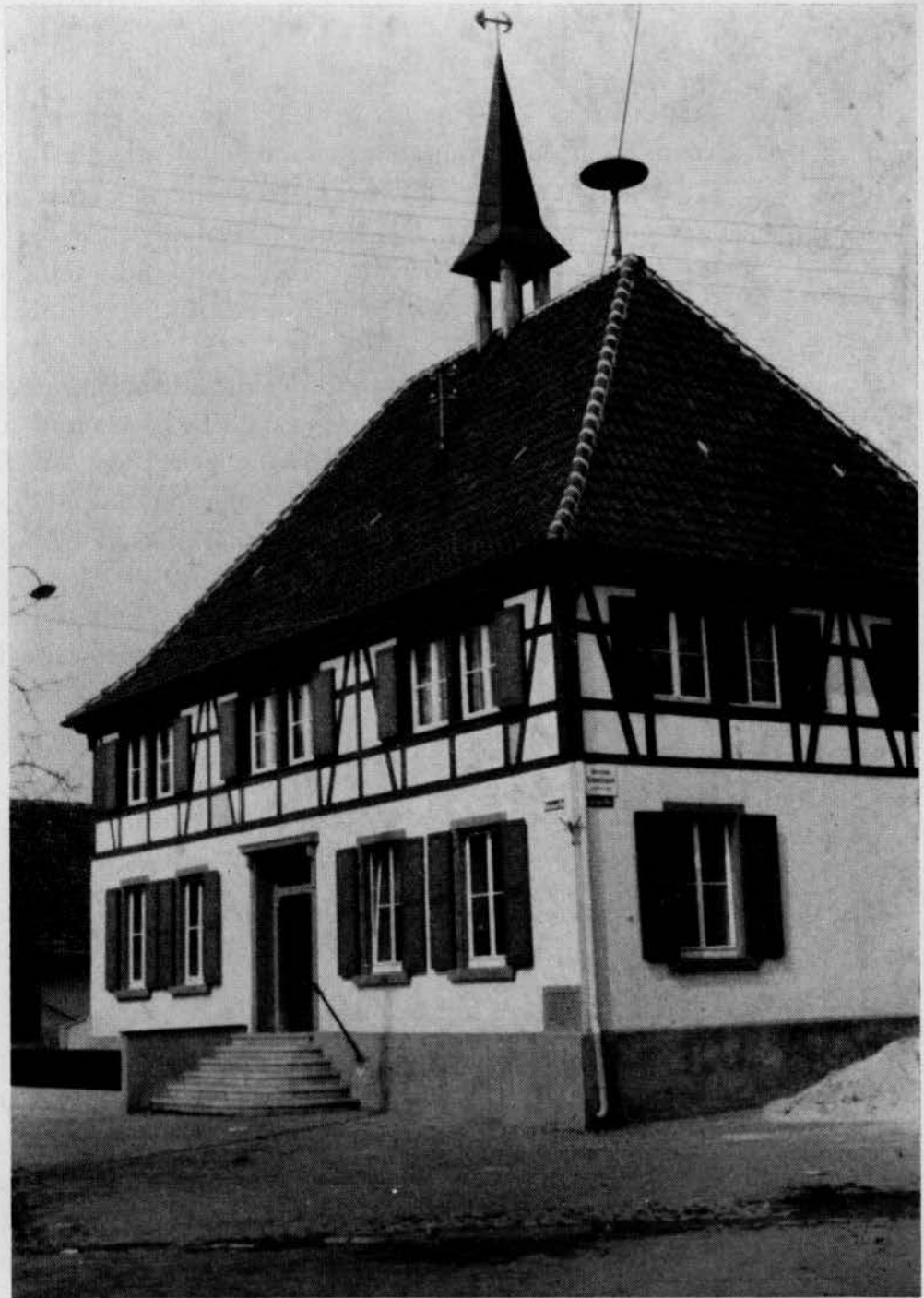
Rathaus von Grauelsbaum, erbaut 1845 als Schul- und Rathaus, auf- gestockt zur Lehrerwohnung 1960.
