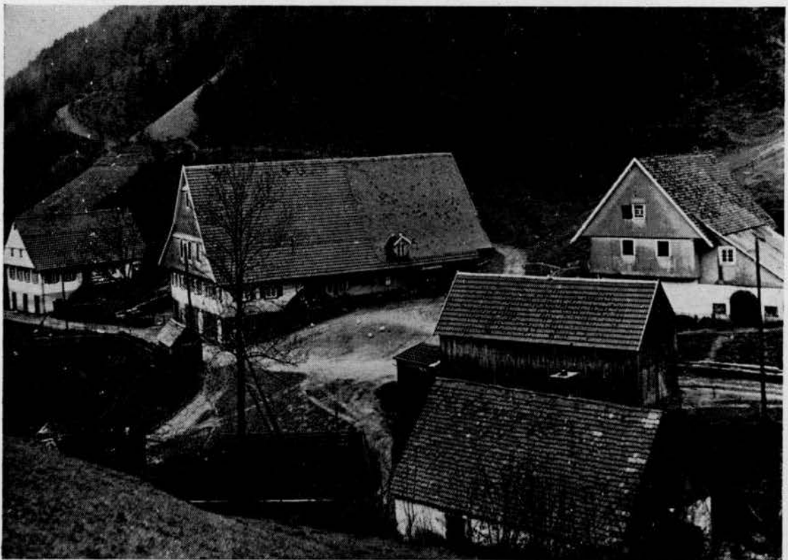
Sulzbächlehof, heute Konradsbauernhof genannt. Von links nach rechts: Das Leibgedinghaus, das Hofgebäude mit Stallungen im Untergeschoß, darüber Wohnteil, Heubühne und Tenne, rechts der Speicherbau mit Keller, davor der Wagenschopf, im Vordergrund am Bach das Wasch- und Backhaus.
